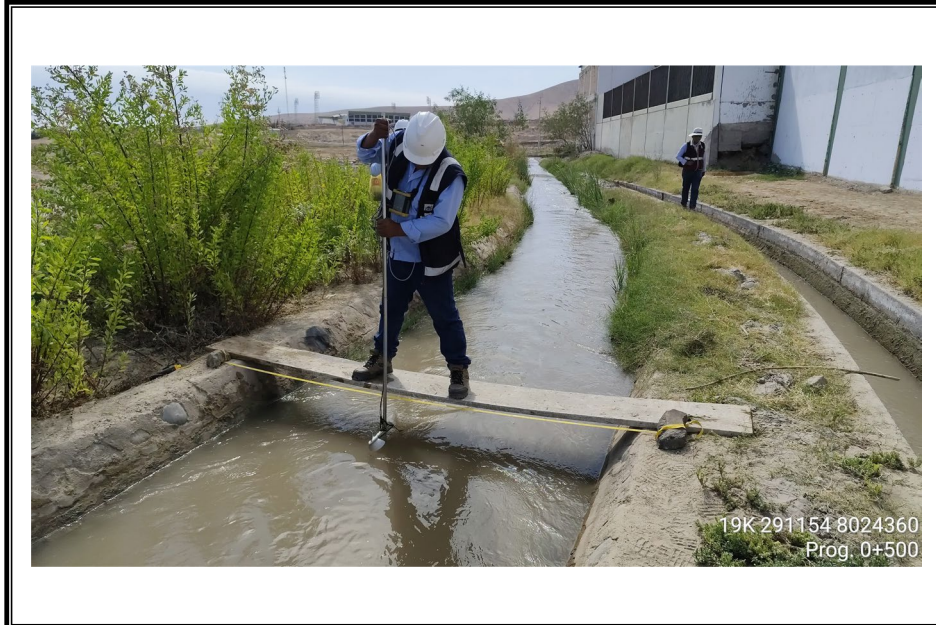
FOTO N° 11: Progresiva 0+500 m. del canal principal del Lateral G.
