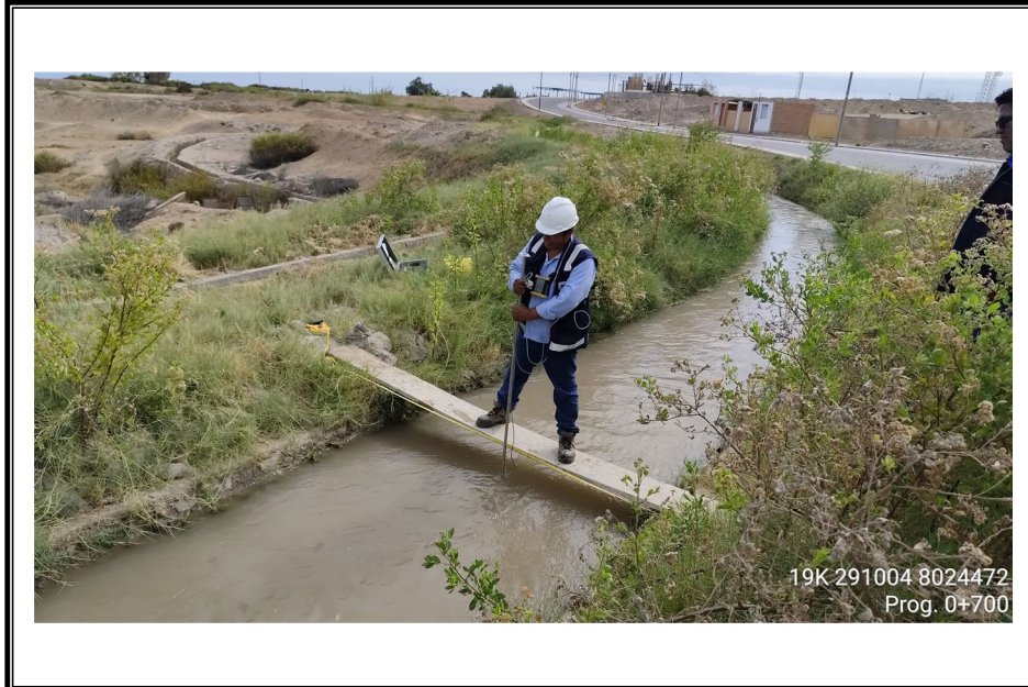
FOTO N° 15: Progresiva 0+700 m. del canal principal del Lateral G.
