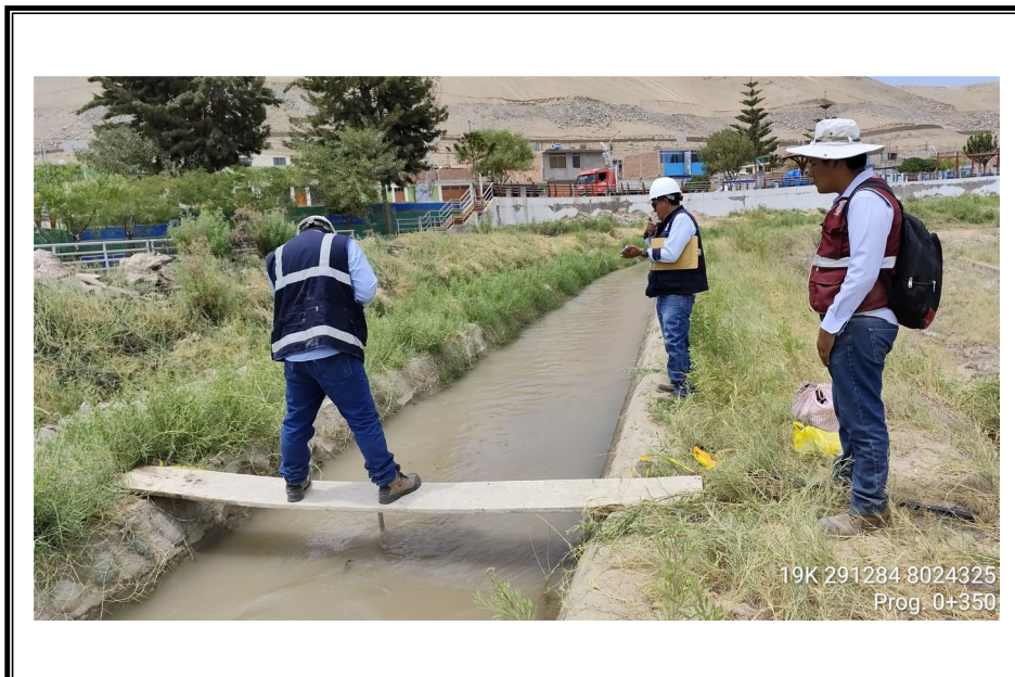
FOTO N° 08: Progresiva 0+350 m. del canal principal del Lateral G.
