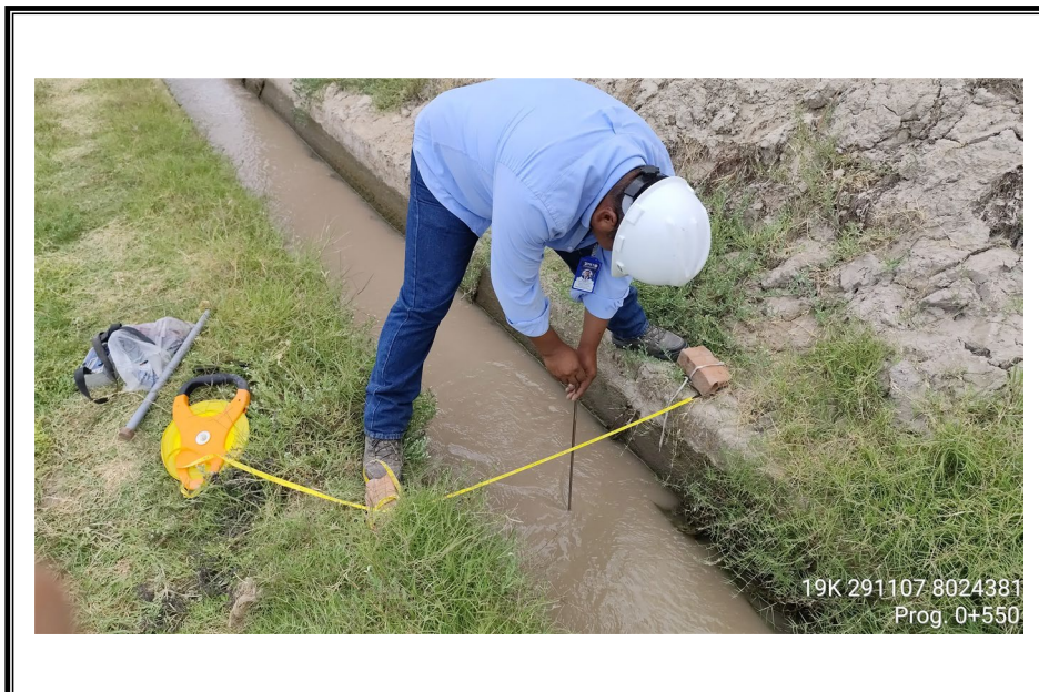
FOTO N° 34: Progresiva 0+550 m. del canal secundario del Lateral G.
