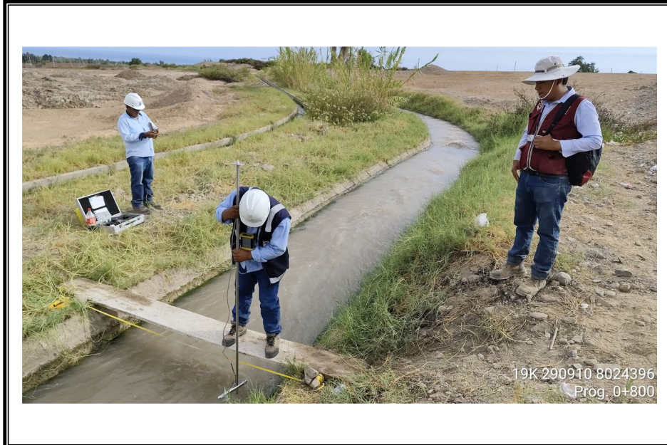
FOTO N° 17: Progresiva 0+800 m. del canal principal del Lateral G.
