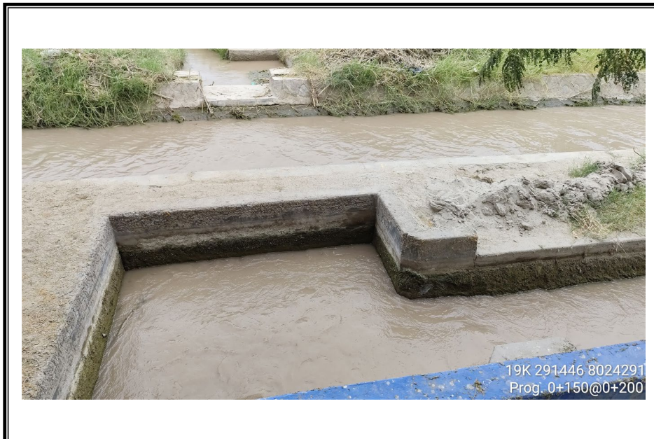
FOTO N° 27: Progresiva 0+200 m. del canal secundario del Lateral G.
