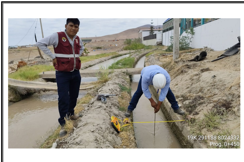
FOTO N° 32: Progresiva 0+450 m. del canal secundario del Lateral G.
