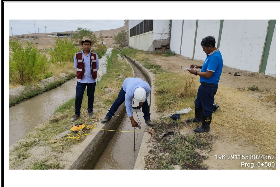
FOTO N° 33: Progresiva 0+500 m. del canal secundario del Lateral G.
