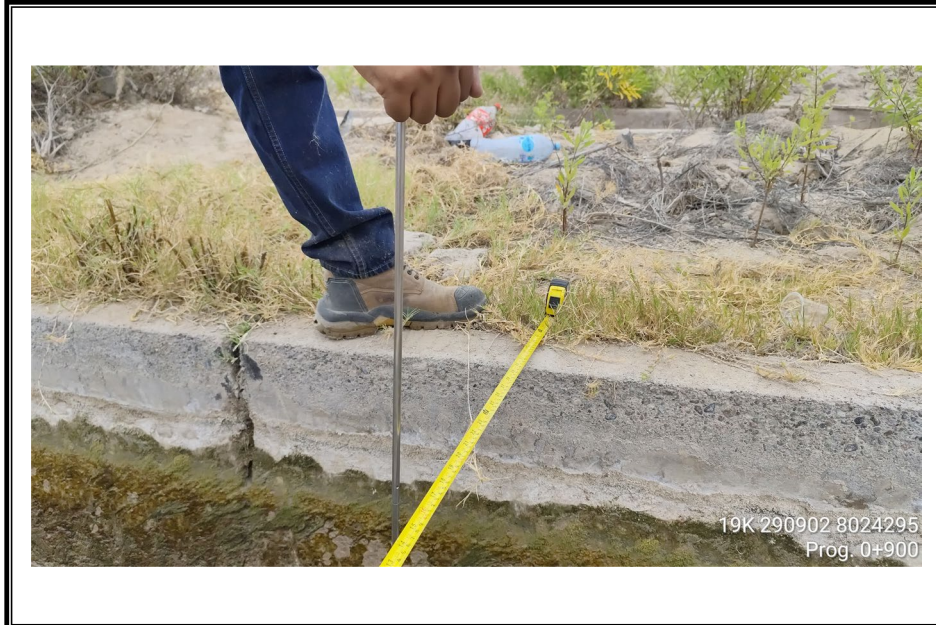
FOTO N° 41: Progresiva 0+900 m. del canal secundario del Lateral G.
