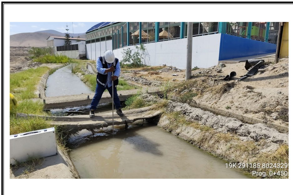
FOTO N° 10: Progresiva 0+450 m. del canal principal del Lateral G.
