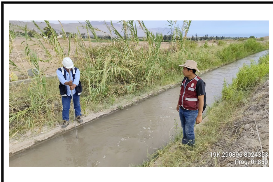
FOTO N° 18: Progresiva 0+850 m. del canal principal del Lateral G.
