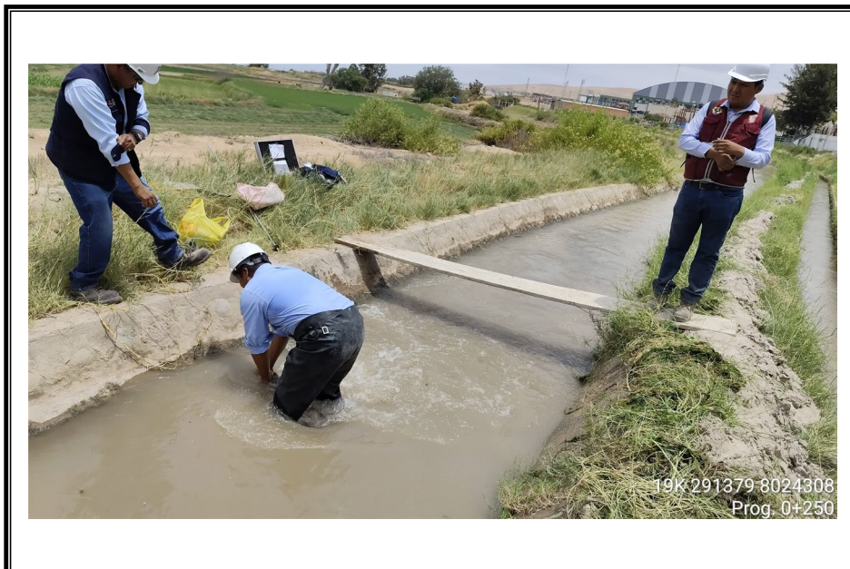
FOTO N° 06: Progresiva 0+250 m. del canal principal del Lateral G.
