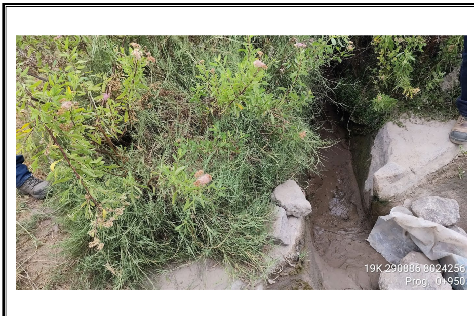
FOTO N° 42: Progresiva 0+950 m. del canal secundario del Lateral G.
