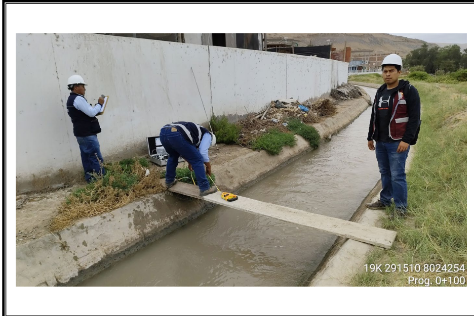
FOTO N° 03: Progresiva 0+100 m. del canal principal del Lateral G.
