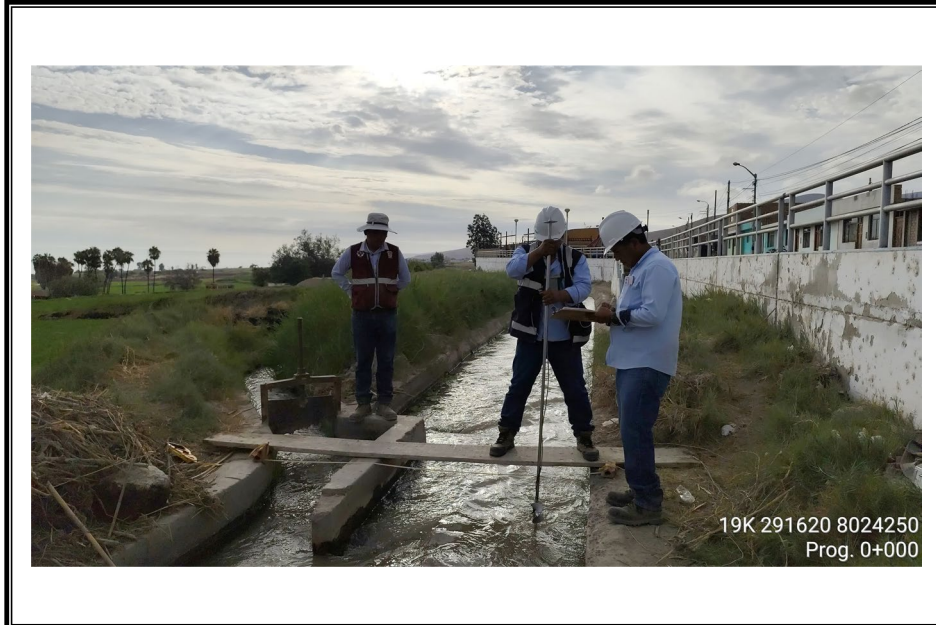
FOTO N° 01: Inicio de progresiva 0+000 m. del canal principal Lateral G.
