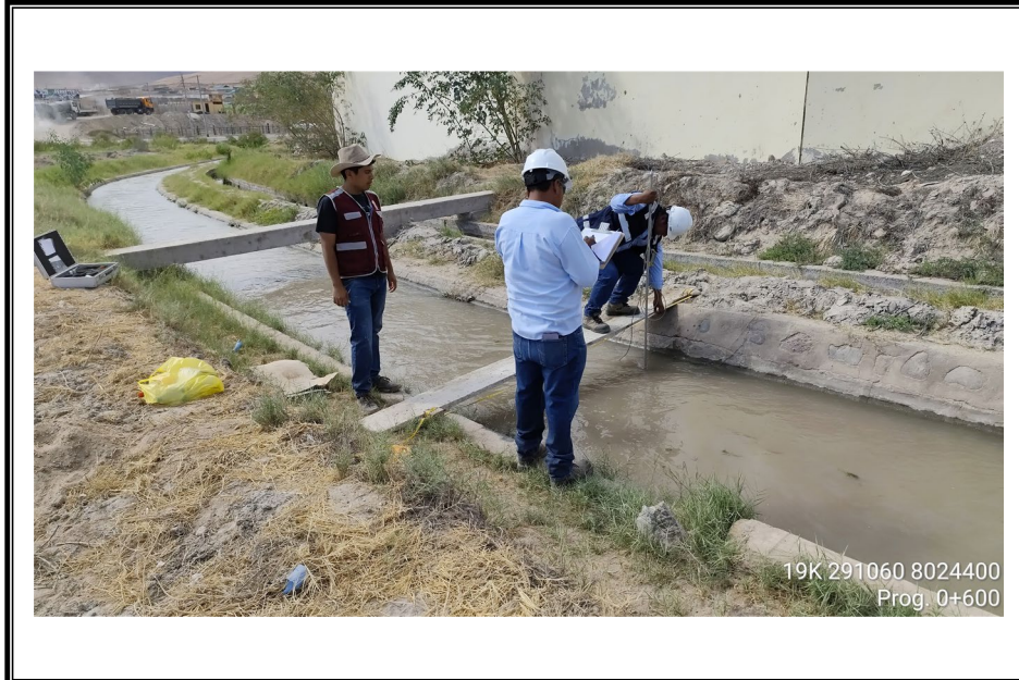
FOTO N° 13: Progresiva 0+600 m. del canal principal del Lateral G.
