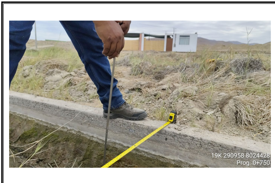
FOTO N° 38: Progresiva 0+750 m. del canal secundario del Lateral G.
