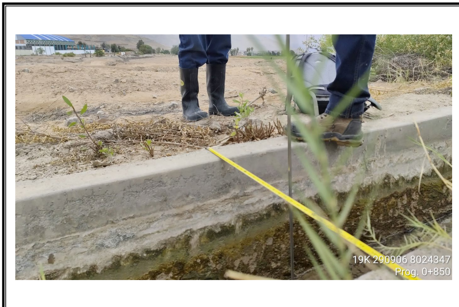
FOTO N° 40: Progresiva 0+850 m. del canal secundario del Lateral G.
