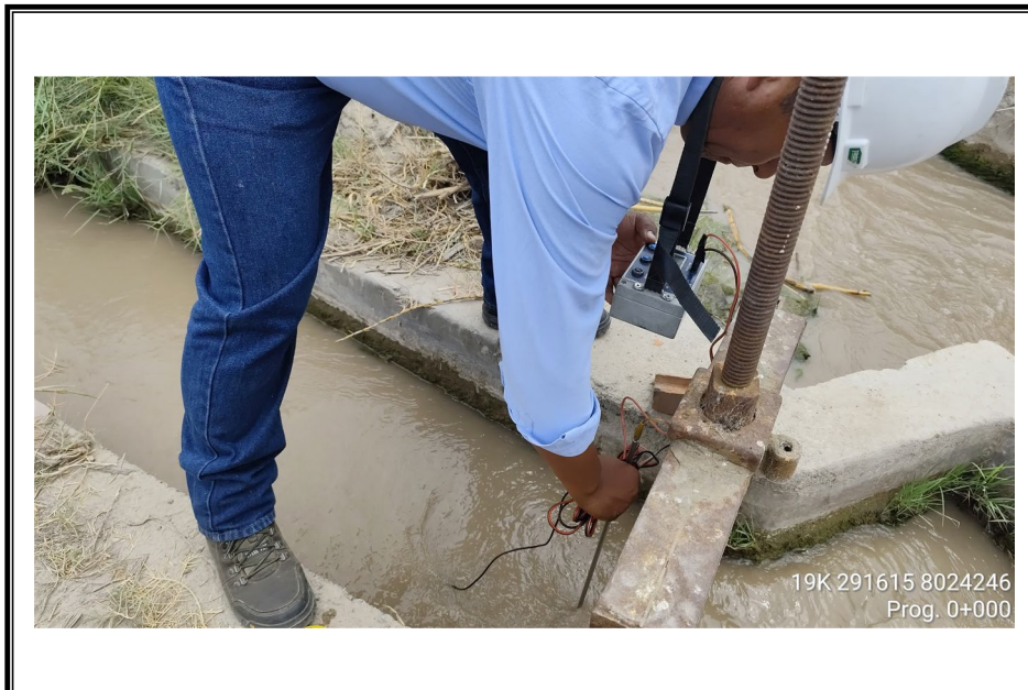
FOTO N° 23: Inicio de progresiva 0+000 m. del canal secundario Lateral G.
