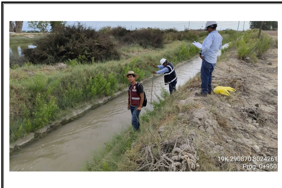
FOTO N° 20: Progresiva 0+950 m. del canal principal del Lateral G.
