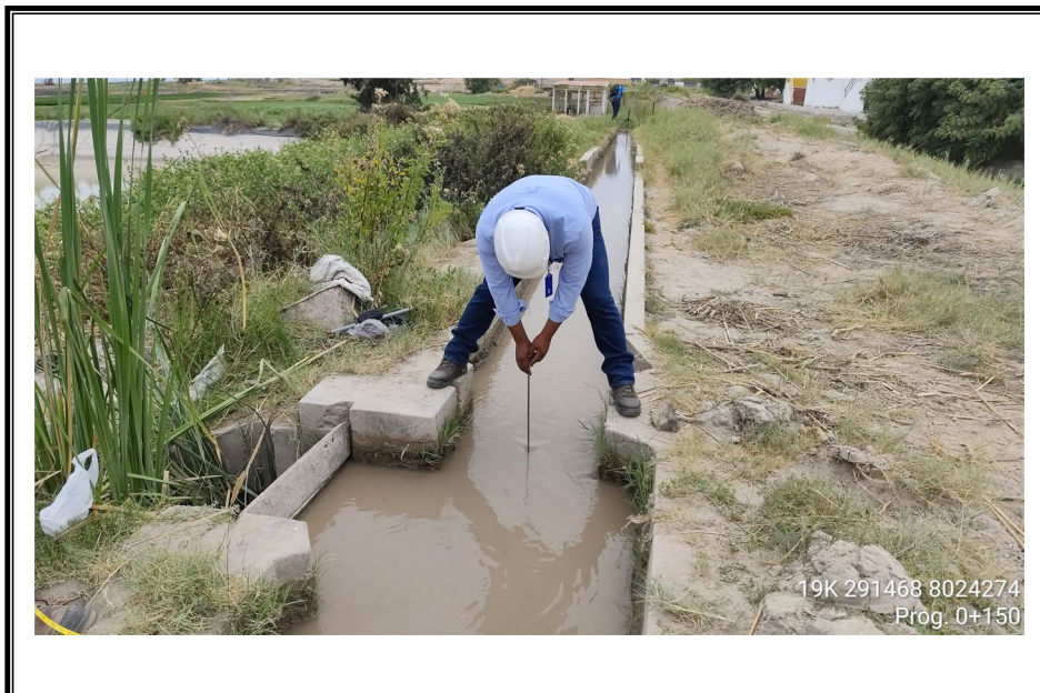
FOTO N° 26: Progresiva 0+150 m. del canal secundario del Lateral G.
