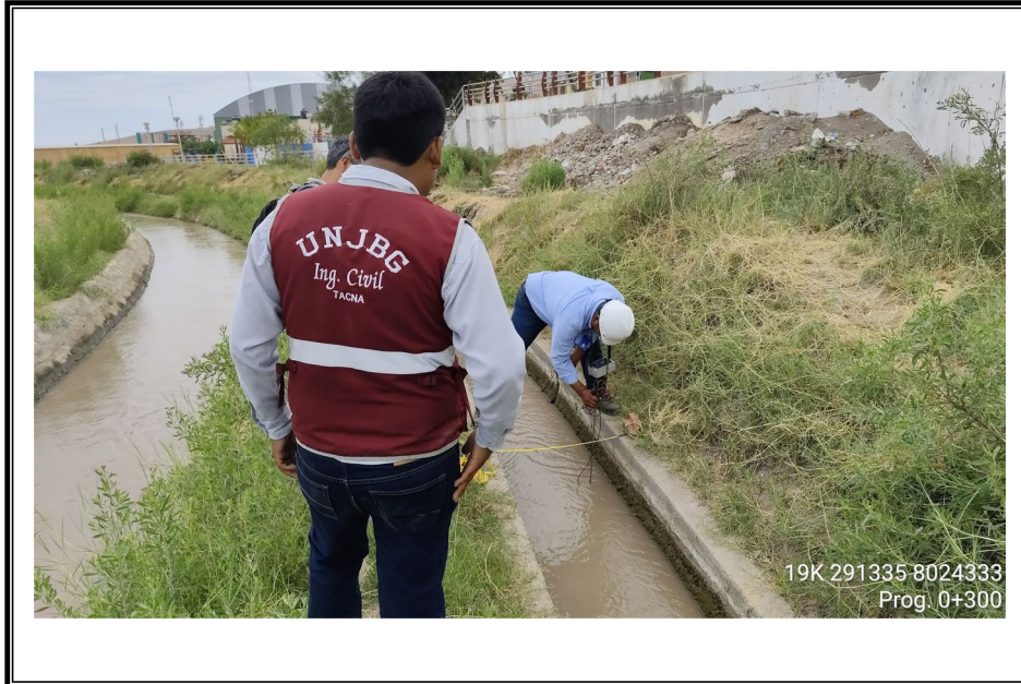
FOTO N° 29: Progresiva 0+300 m. del canal secundario del Lateral G.
