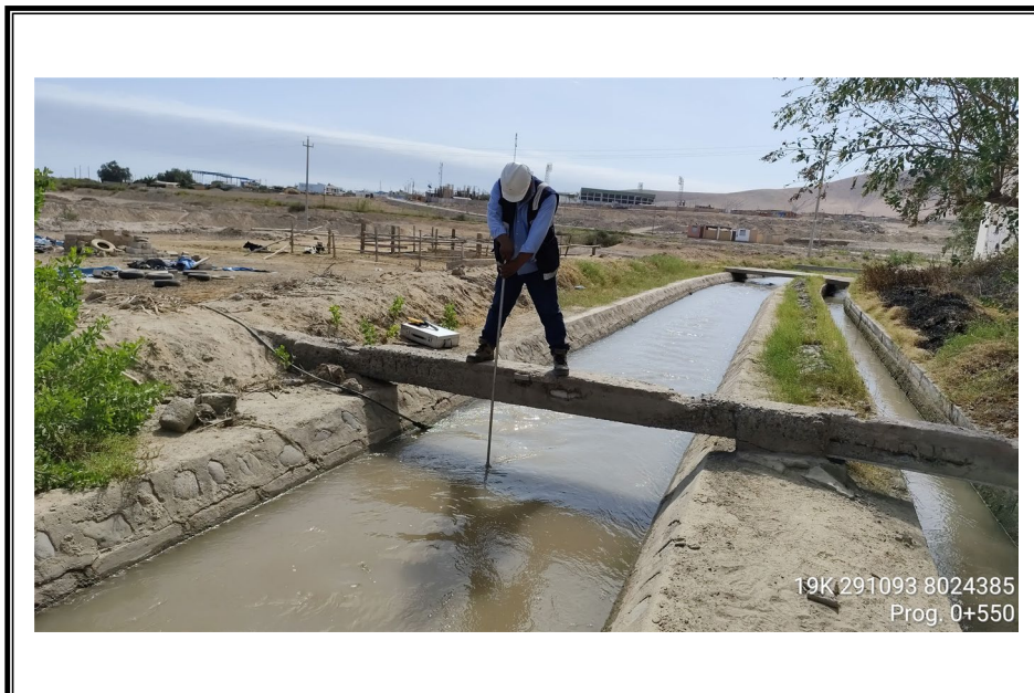
FOTO N° 12: Progresiva 0+550 m. del canal principal del Lateral G.
