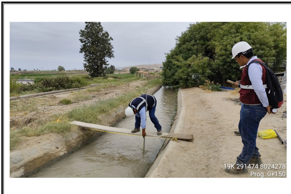
FOTO N° 04: Progresiva 0+150 m. del canal principal del Lateral G.
