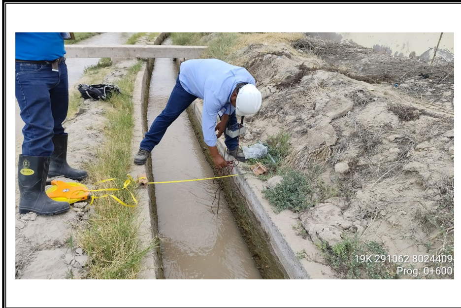
FOTO N° 35: Progresiva 0+600 m. del canal secundario del Lateral G.
