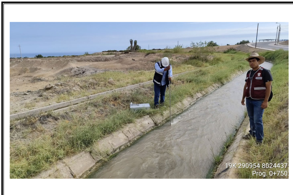
FOTO N° 16: Progresiva 0+750 m. del canal principal del Lateral G.
