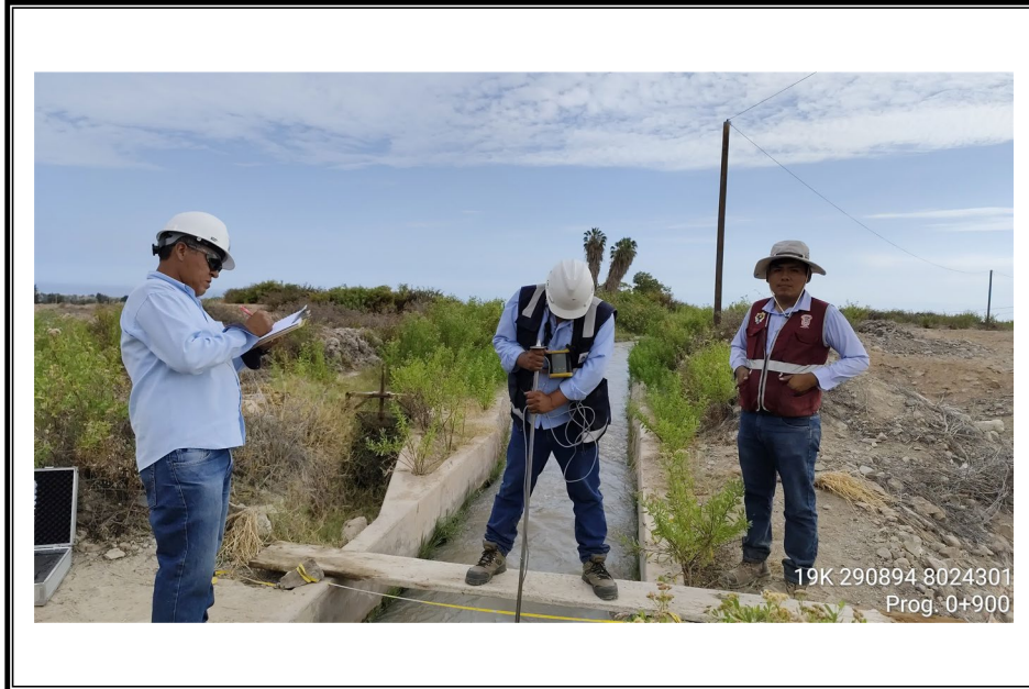
FOTO N° 19: Progresiva 0+900 m. del canal principal del Lateral G.
