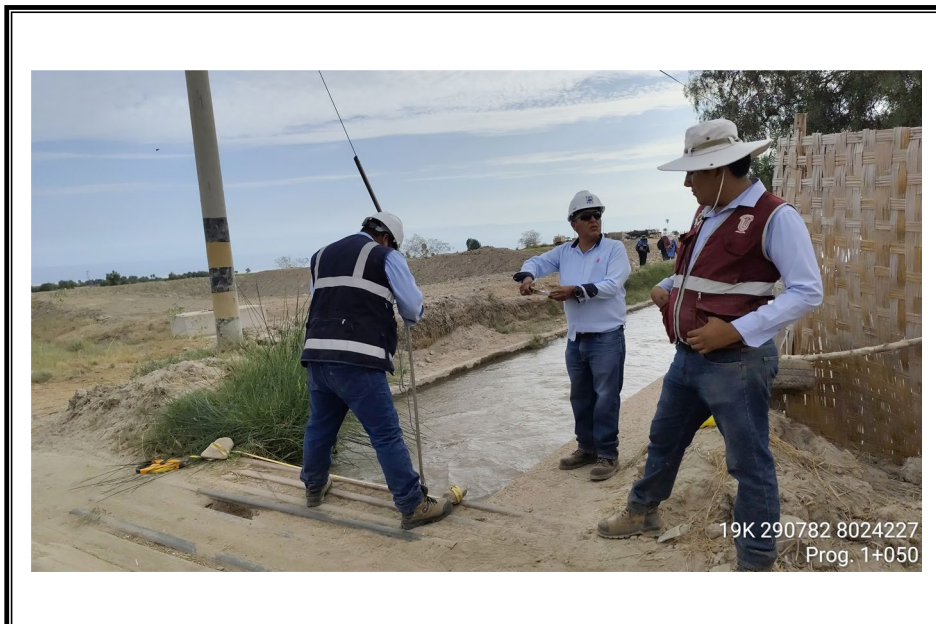
FOTO N° 22: Progresiva 1+050 m. del canal principal del Lateral G.
