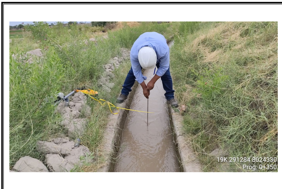
FOTO N° 30: Progresiva 0+350 m. del canal secundario del Lateral G.
