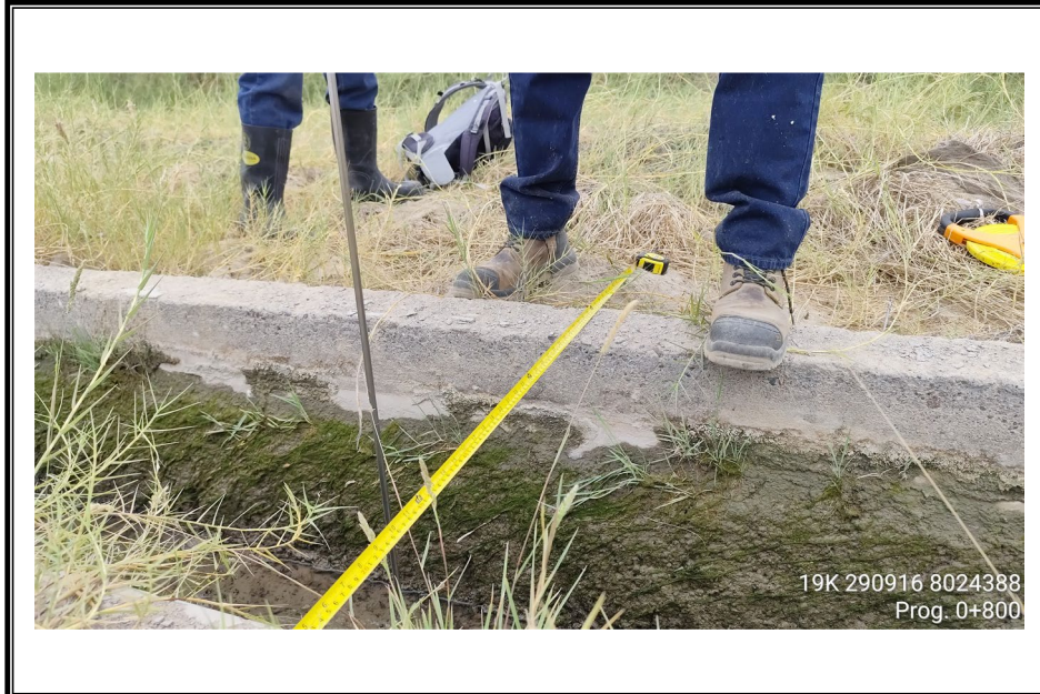
FOTO N° 39: Progresiva 0+800 m. del canal secundario del Lateral G.
