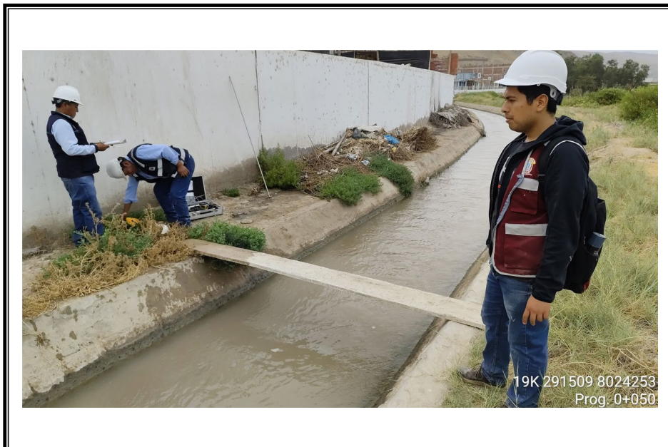
FOTO N° 02: Progresiva 0+050 m. del canal principal del Lateral G.
