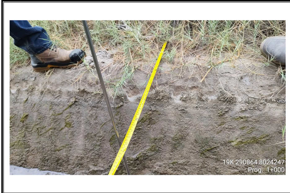
FOTO N° 43: Progresiva 1+000 m. del canal secundario del Lateral G.
