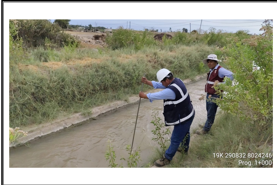
FOTO N° 21: Progresiva 1+000 m. del canal principal del Lateral G.
