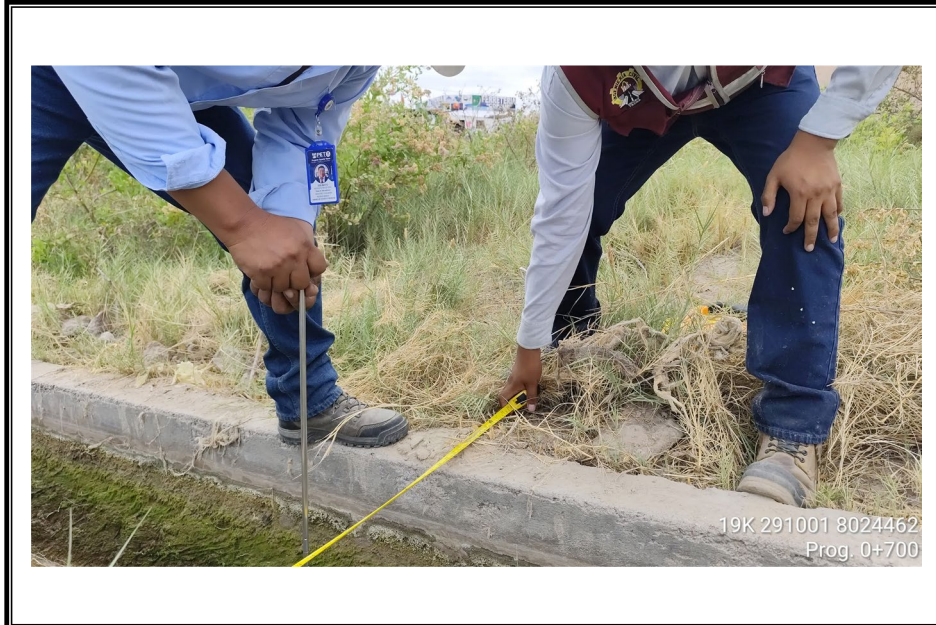
FOTO N° 37: Progresiva 0+700 m. del canal secundario del Lateral G.
