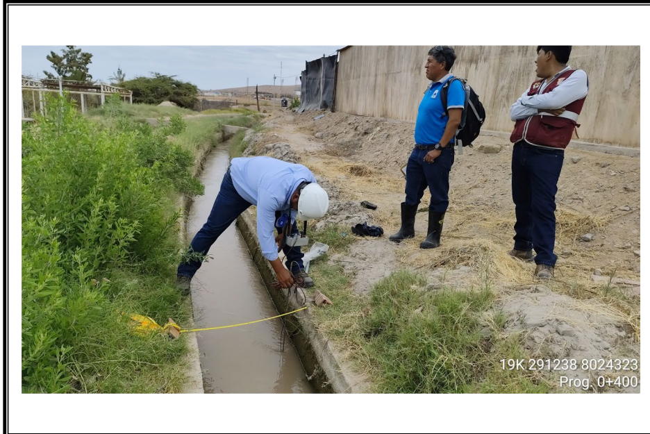
FOTO N° 31: Progresiva 0+400 m. del canal secundario del Lateral G.
