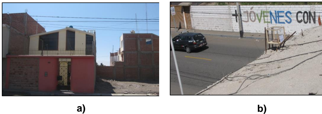
Figura 16. Vista exterior del domicilio en la calle General Suarez; a) Fachada principal y b) Vista de la ubicación final del líquen
