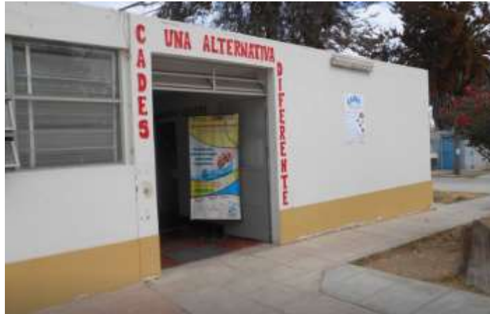
Figura 12. VISTA EXTERIOR DEL CENTRO DE ATENCIÓN AMBULATORIA Y DE DÍA PARA CONSUMIDORES Y DEPENDIENTES DE SUSTANCIAS PSICOACTIVAS – PUERTA 1
