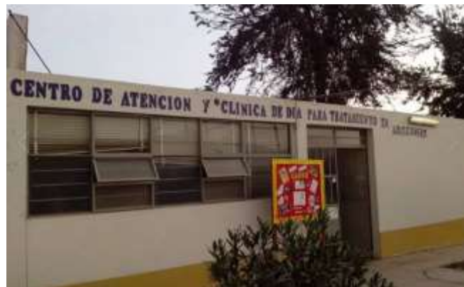
Figura 13. VISTA EXTERIOR DEL CENTRO DE ATENCIÓN AMBULATORIA Y DE DÍA PARA CONSUMIDORES Y DEPENDIENTES DE SUSTANCIAS PSICOACTIVAS – PUERTA 2
