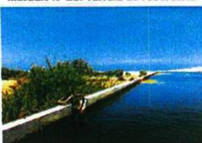
IMAGEN N° 23: válvula de reservorio
