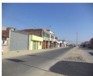
VIAS ASFALTADAS – AV. LOS MOLLES
