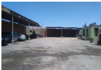
Figura N° 05. Zona de Equipo Mecánico
