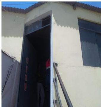
Figura N° 67. Oficina de catastro y rural
