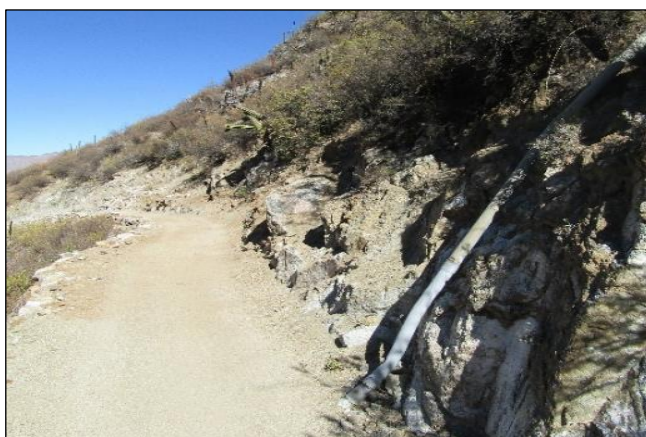
Figura 23. Tubería para abastecimiento de agua
