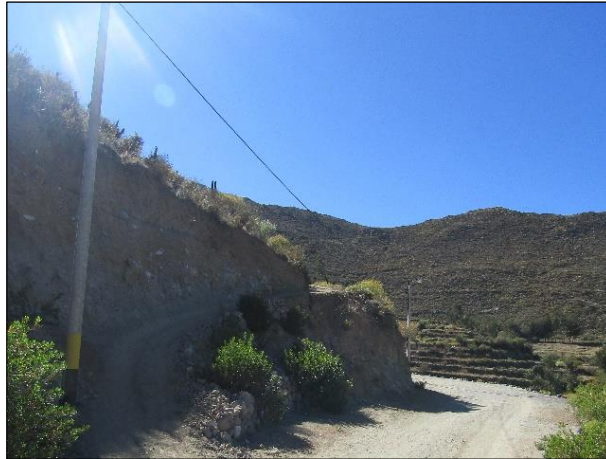
Figura 195. Red de conexión de energía eléctrica
