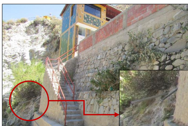
Figura 184. Evacuación de aguas usadas
