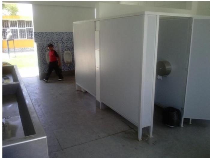
Vista general de los servicios sanitarios - Primaria
