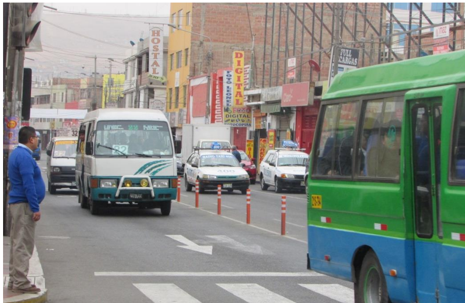
IMAGEN 6. Estado de conservación de la vía Av. Patricio Meléndez Fuente propia
