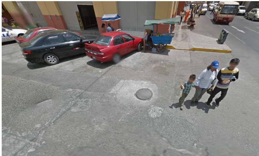
IMAGEN 15. Pozo de desagüe en la Av. Dos de Mayo Fuente propia
