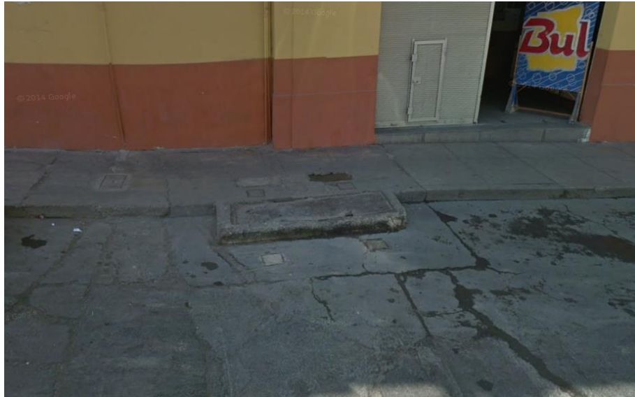
IMAGEN 14. Cajas de registro en la Ca. Fermín Nacarino Fuente propia
