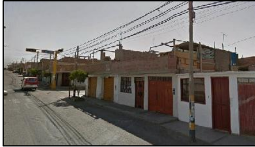
Figura N° 47: Estado de las Vías - Av. Juan Moore.
