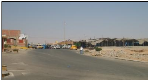
Figura N° 49: Estado de las Vías – Av. Mariano Necochea.
