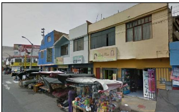
Figura N° 43: Estado regular de las edificaciones dentro del ámbito de estudio.
