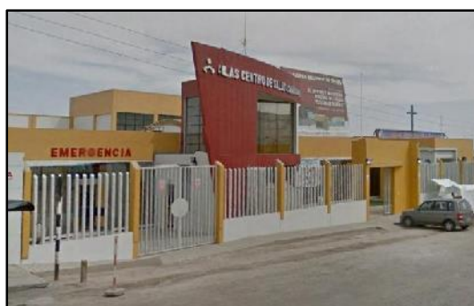
Figura N° 72: Construcciones sismo resistente existentes.
