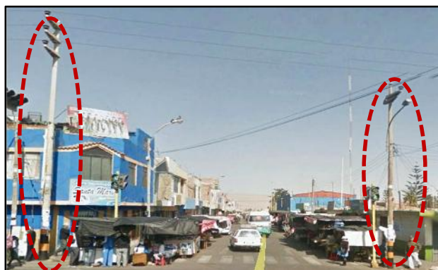
Figura N° 63: Sistema Eléctrico en el Ámbito de Estudio.
