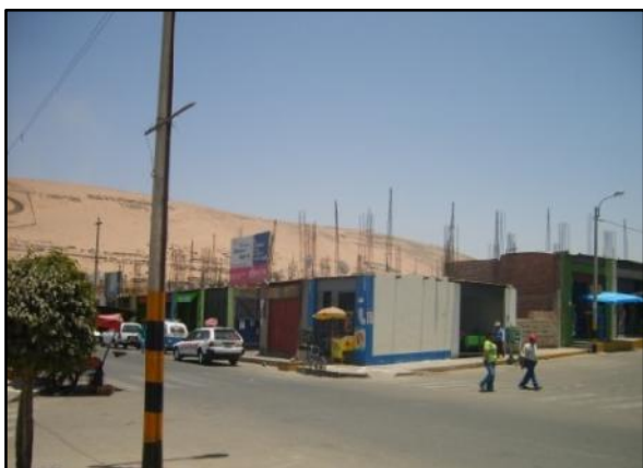
Figura N° 21: Vista Exterior - Mercado Sectorial Alfonso Ugarte.
