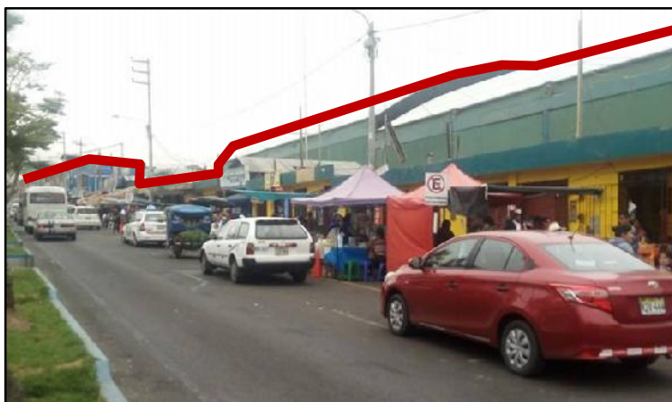
Figura N° 41: Altura de Edificación existente del mercado
