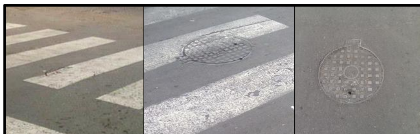
Figura N° 62: Buzones de desagüe en el Ámbito de Estudio.
