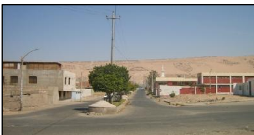
Figura N° 51: Estado de las Vías – Av. Manuel Cuadros.
