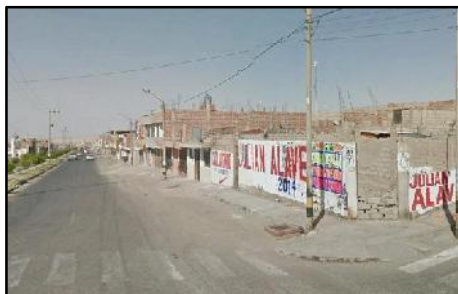
Figura N° 48: Estado de las Vías - Av. El Sol.
