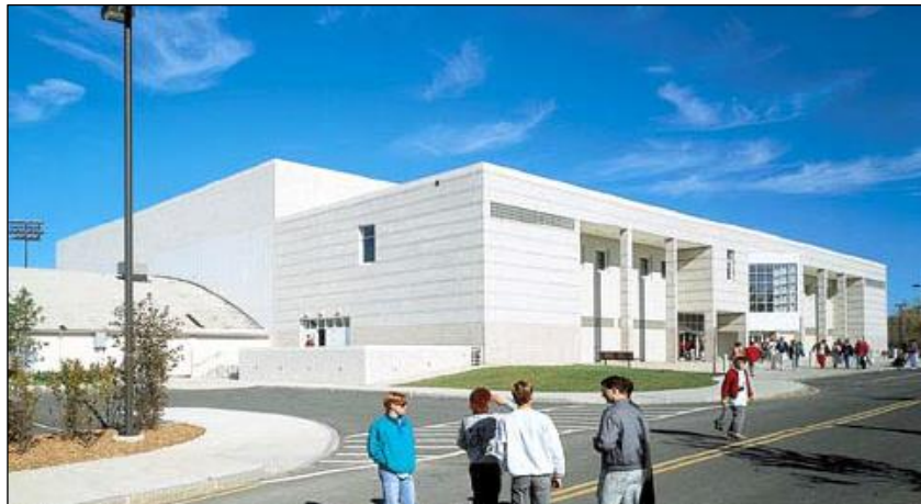
Imagen N° 20 CORNELL UNIVERSITY - FACHADA EXTERIOR
