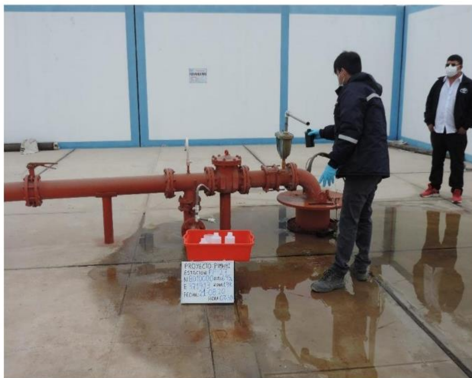
Fotografía 11 Muestreo de agua a nivel de salida del pozo de bombeo FP-27, ubicado en el Parque Perú.
