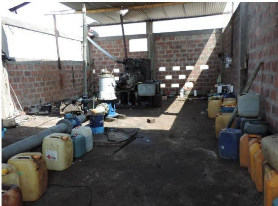
Fotografía 10. Bombeo del pozo FP-33, ubicado en el sector de Magollo.
