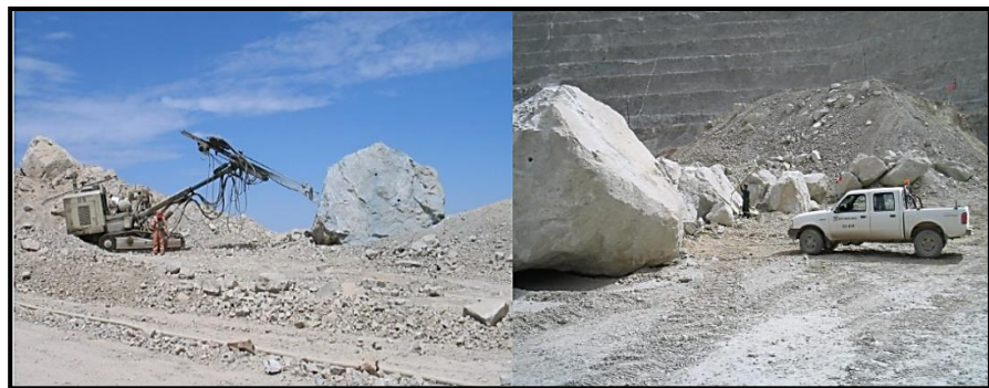
Figura 1. Acomodo de material para perforación secundaria Fuente: Departamento de perforación y voladura, mina Toquepala, 2012.
