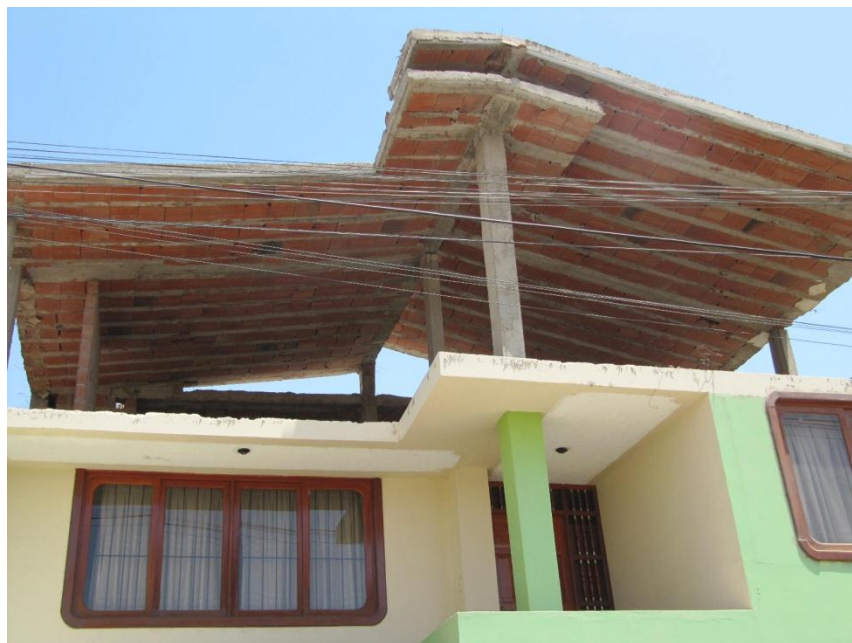
Fotografía 7: Tercera planta muy flexible en comparación con la segunda
