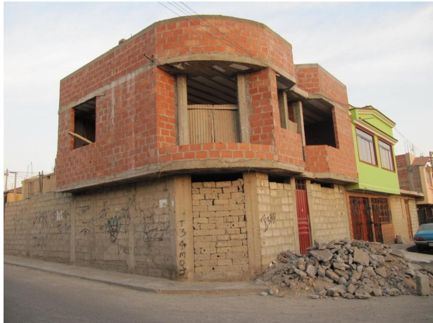
Fotografía 14: Algunas viviendas usan diferentes tipos de unidades de albañilería
