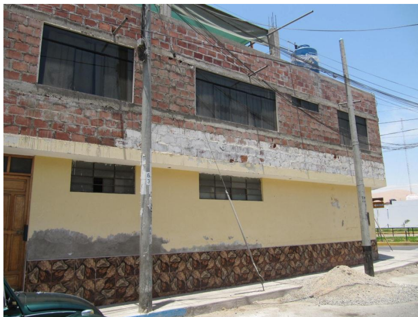
Fotografía 2: Segundo piso con anillo de amarre a nivel de alféizar
