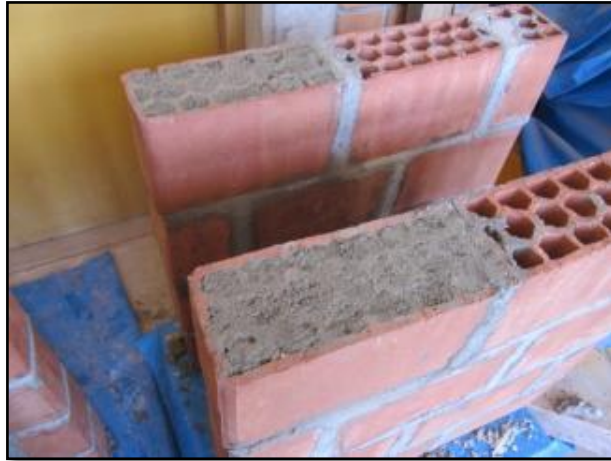
Fig. 27 Taponeo con mortero 1:3 de los vértices del murete de albañilería
