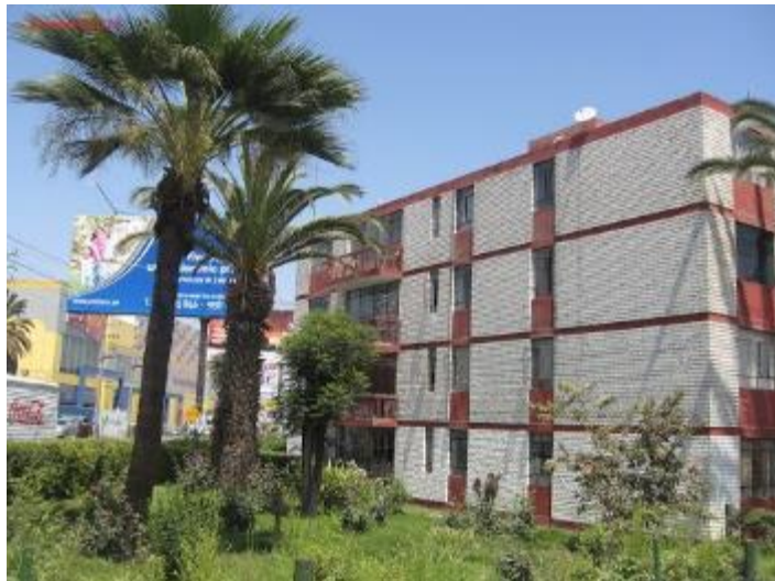
Fig. 1: Edificios antiguos de albañilería simple en Tacna
