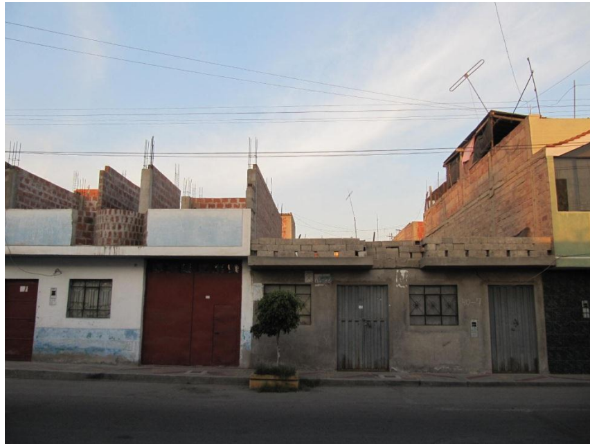
Fotografía 11: La mayoría de las viviendas son de Bloquetas y Ladrillos Blocker II
