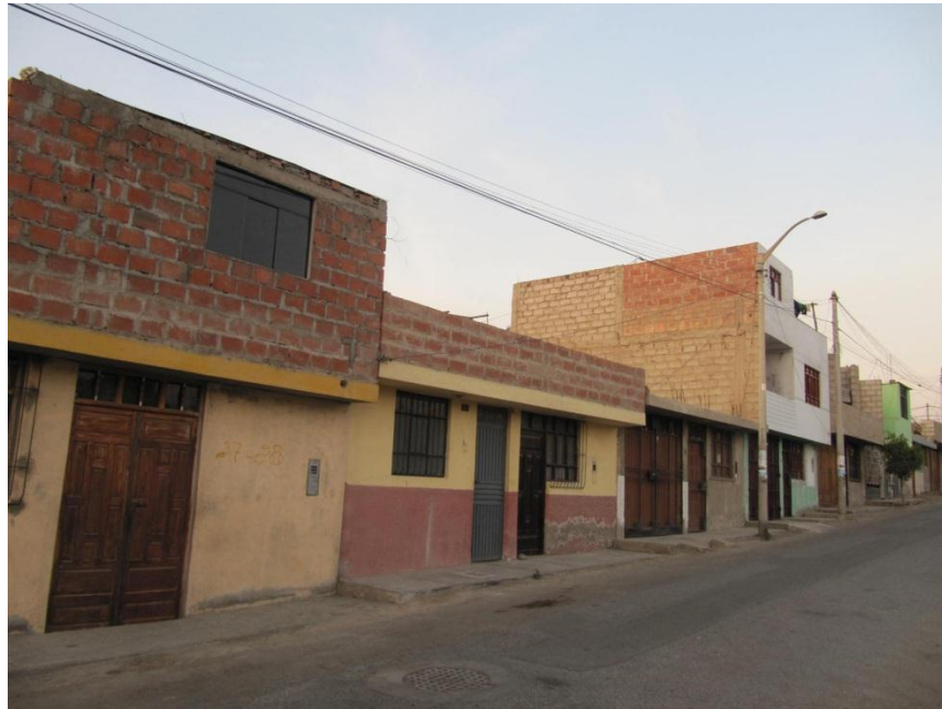
Fotografía 13: Diferentes viviendas donde predominan el Blocker II y la bloqueta
