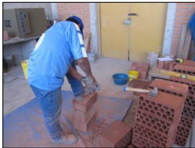
Fig. 26 Cortado de los ladrillos para construcción del murete de Blocker II
