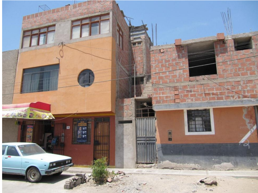
Fotografía 9: Viviendas con muros esbeltos de Blocker II
