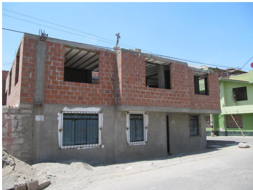
Fotografía 10: Segunda planta de ladrillos Blocker II y techo aligerado con polipropileno expandido
