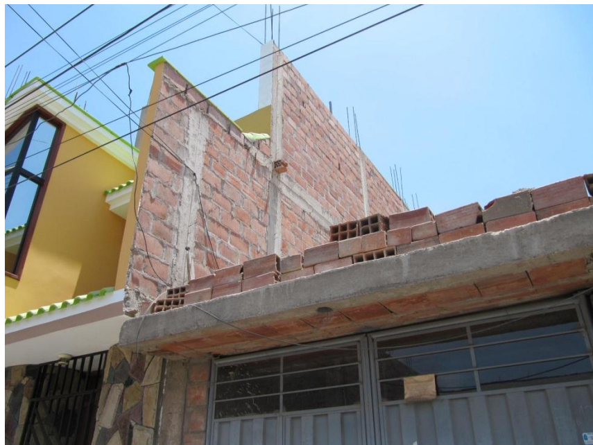
Fotografía 4: Se aprecian los elementos de confinamiento
