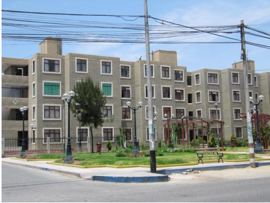
Fotografía 5: Edificios multifamiliares de albañilería confinada
