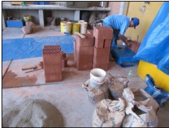
Fig. 21 Albañil preparando materiales para construcción los prismas de albañilería
