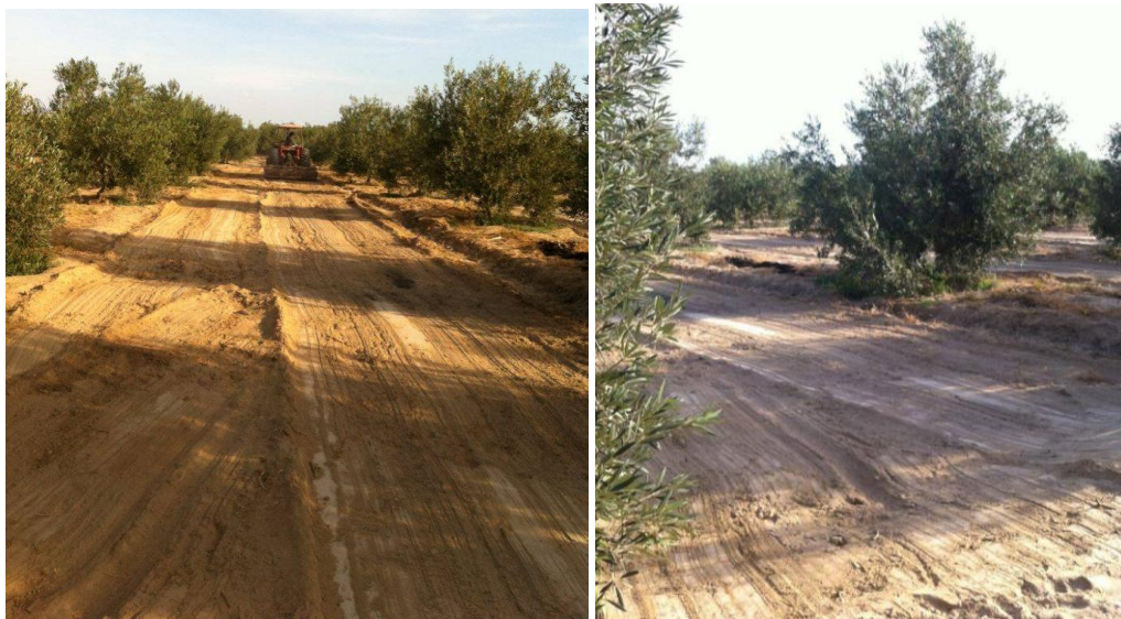
Fotografía 01: Nivelación del campo experimental
