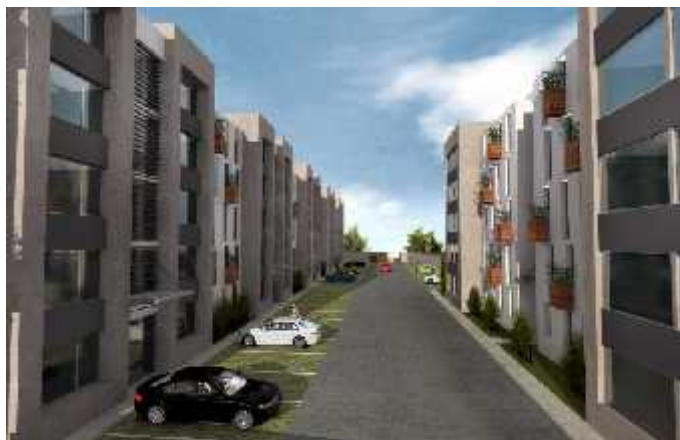
Figura 17. Proyecto: Residencial Torres de Dos de Mayo
