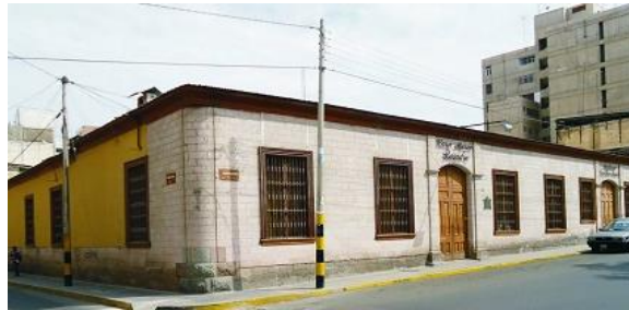
Fachada de la Casa Basadre
