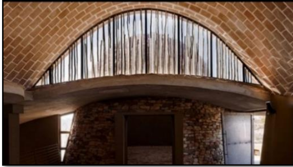
Imagen N° 41: Técnica utilizada para la ejecución de las bóvedas tabicadas.
