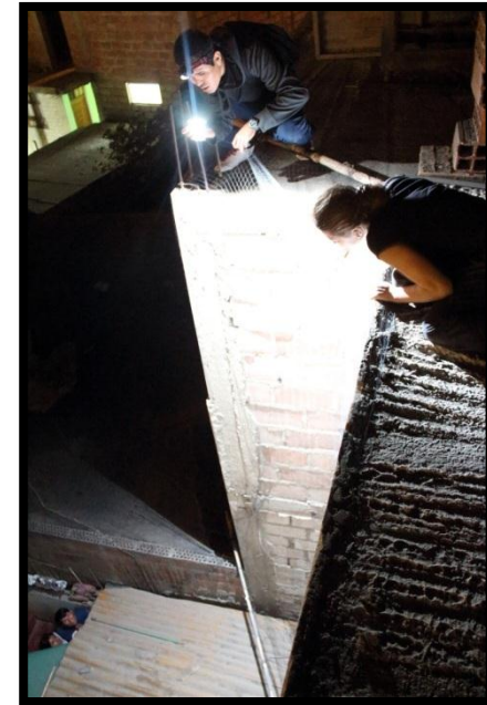
ANEXO 09: Instalación de las mallas en el Cercado de Tacna
