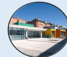
Áreas exteriores fachada sur
