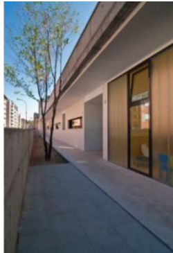
Área exterior fachada norte
