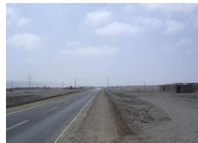
Construcción de acceso vial en el km 34+580
