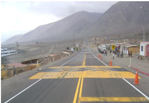
Asociaciones de vivienda instalados en el Derecho de Vía ocasiona la proliferación de dispositivos de seguridad vial, reductor de velocidad Puerto Grau km 76+000
