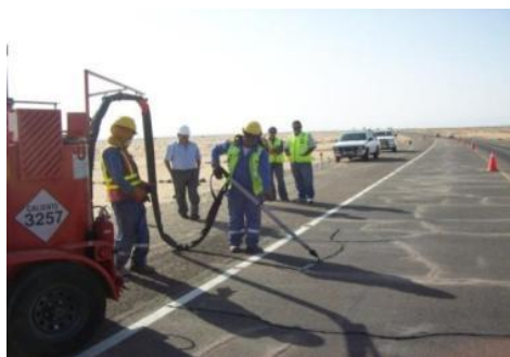
Sellado de fisuras
