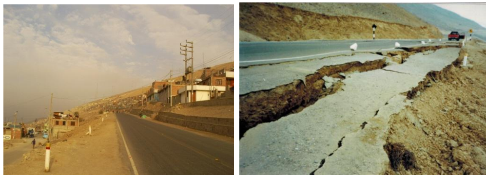
Fig. 3.3.2.Q Geodinámicas en las zonas aledañas a la carretera
