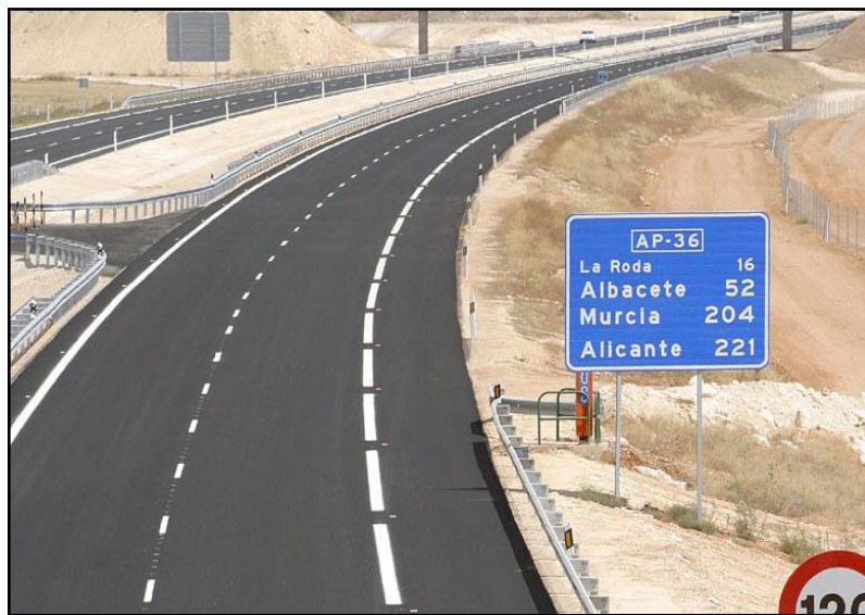
Fig. 3.3.3.E Vista de ampliación de la carretera La Costanera
