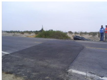
Progresiva 12+020, corte para pase de agua
