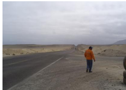
Construcción de acceso vial en el km 93+100
