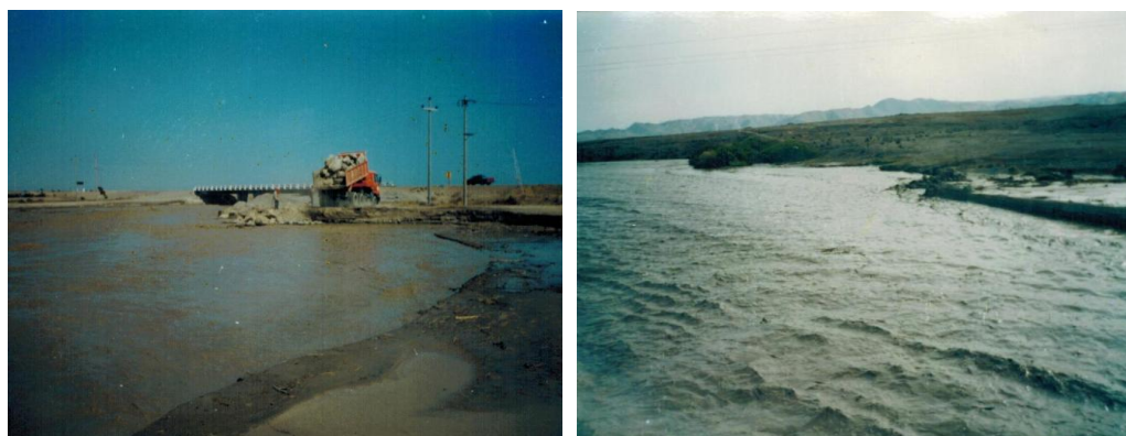
Trabajos de enrocamiento y encauzamiento del río Sama
