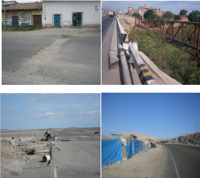
Fig. 2.4.H Invasiones en el Derecho de Vía
