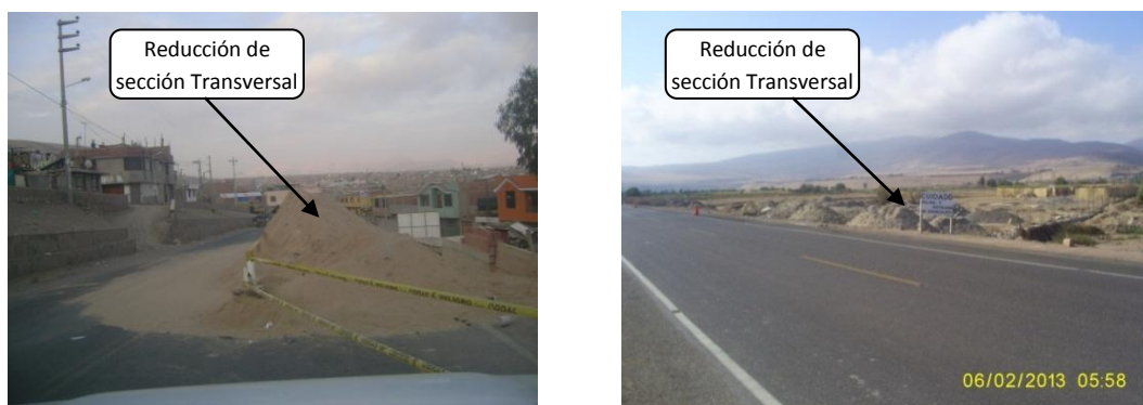
Fig. 3.3.1.1 Reducción de sección transversal en la carretera La costanera por invasiones
