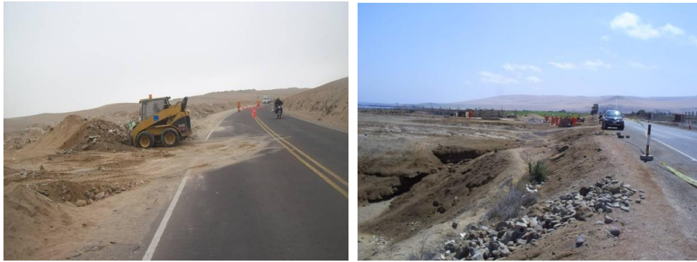
Fig. 3.3.2.I Remoción de desmontes en el Derecho de Vía
