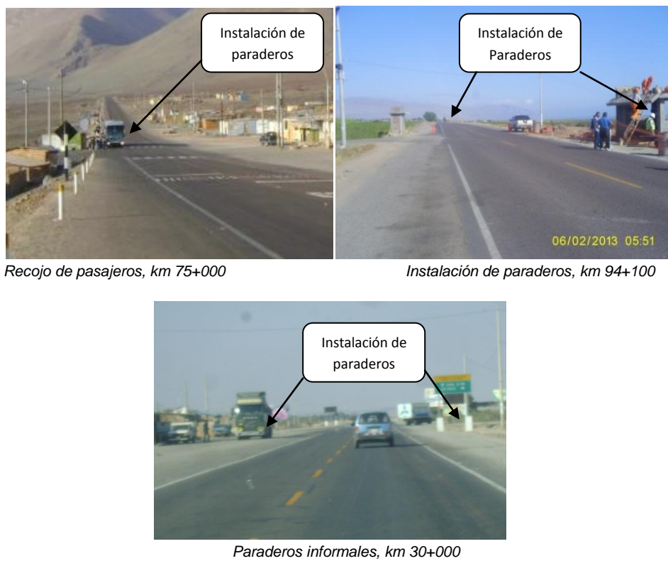
Fig. 3.3.1. M Instalación de paraderos y de estacionamientos en La Costanera
