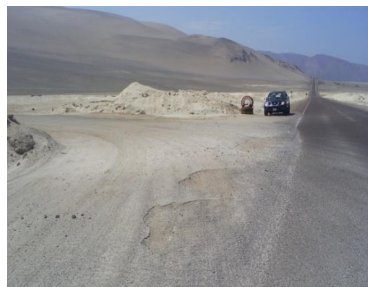
Construcción de acceso vial en el km 93+010
