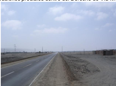
Acceso para invasiones prediales - km 35+000
