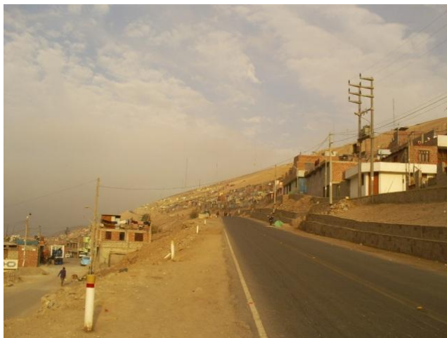
Fig. 3.3.3.I Asociaciones de vivienda instalados en el Derecho de Vía
