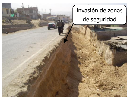
Progresiva km 2+000 (Carretera Tacna - Tarata)
