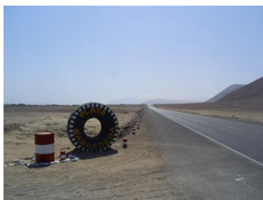
Construcción de acceso vial en el km 56+500
