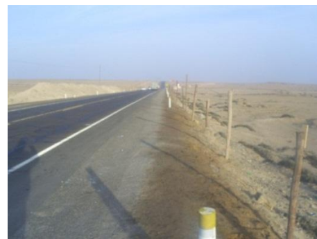
Instalación de cercos perimétricos
