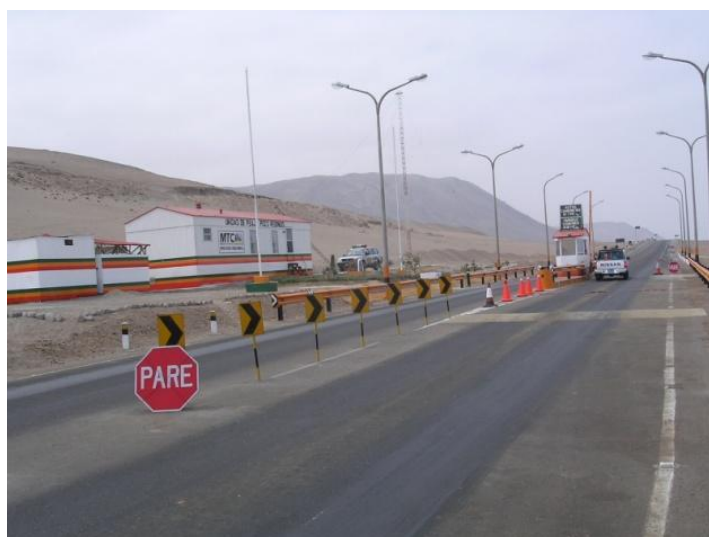
Fig. 2.3.C Caseta de cobro de peaje Pozo Redondo La Costanera, km 55+000
