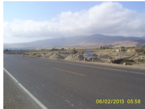
Arrojo de desmonte, progresiva km 93+000
