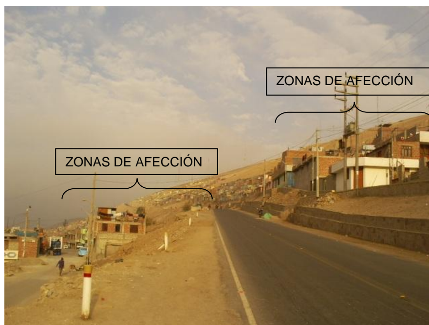
Fig. 2.4.A Carreteras Tacna – Tarata, Invasión de las zonas de afección de la carretera
