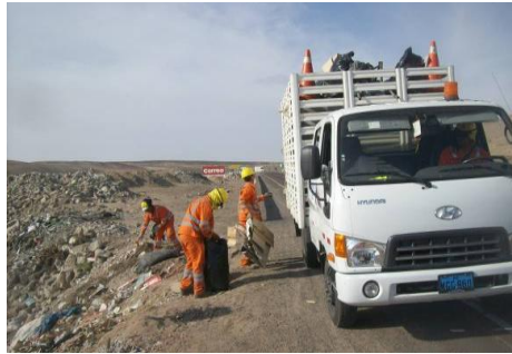
Fig. 3.3.2.G Limpieza general en el Derecho de Vía
