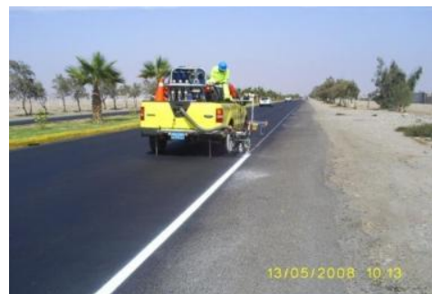
Repintado de marcas en el pavimento
