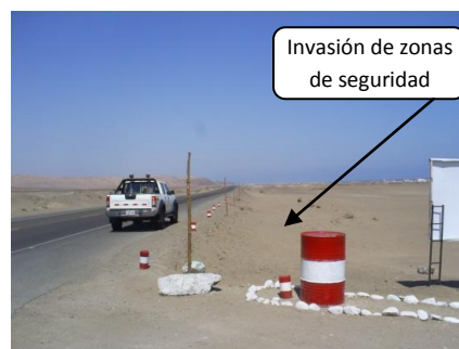
Progresiva km 53+000, obras civiles
