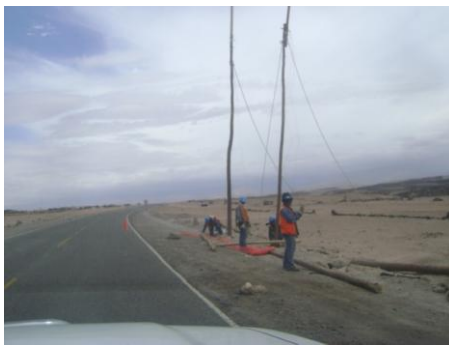
Instalación de postes de luz
