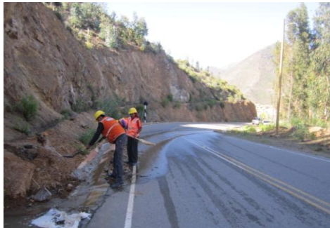
Fig. 3.3.2.J Remoción de desmontes en el Derecho de Vía
