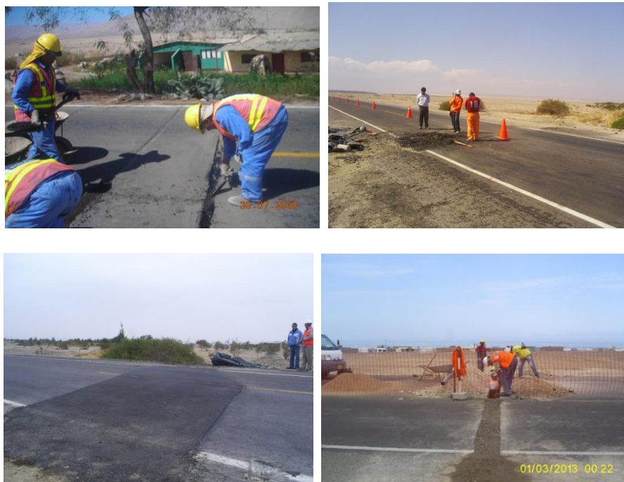
Fig. 3.3.2.K Baches en el Derecho de Vía
