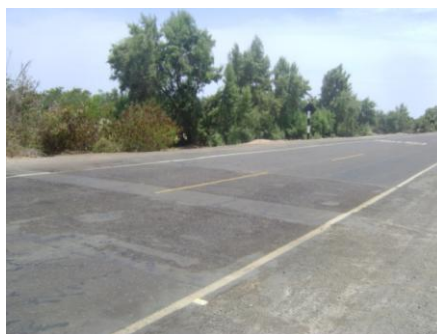
Cortes para pase de agua en carretera km 35+450
