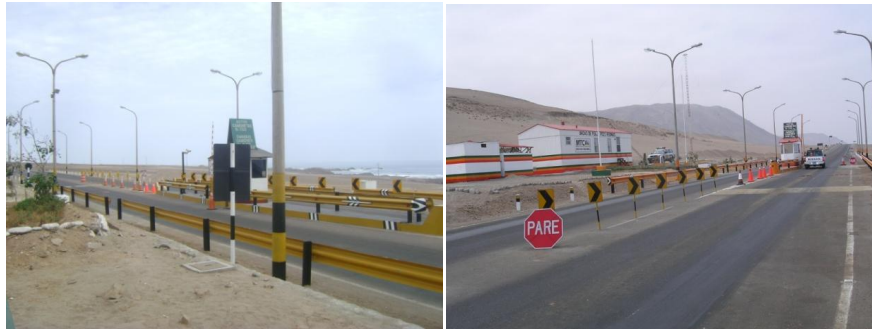
Fig. 3.3.3.B Caseta de cobro de peaje de La Costanera peaje Pozo Redondo km 58+500
