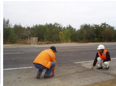
Progresiva 29+250, corte para pase de agua
