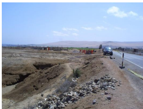
Arrojo de desmontes, progresiva km 90+000
