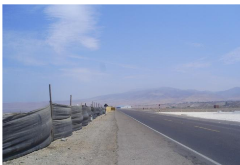
Progresiva Km 93+000 La Costanera
