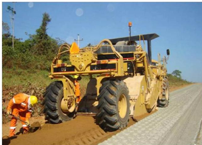
Fig. 2.1.D Construcción de la carretera
