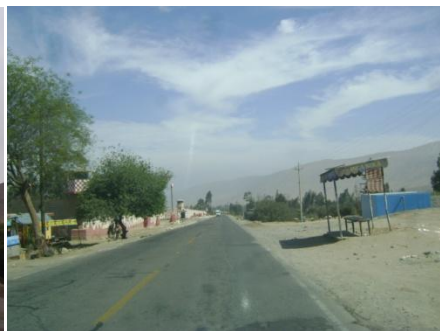
Carretera Tacna – Palca (Cuartel Miculla)
