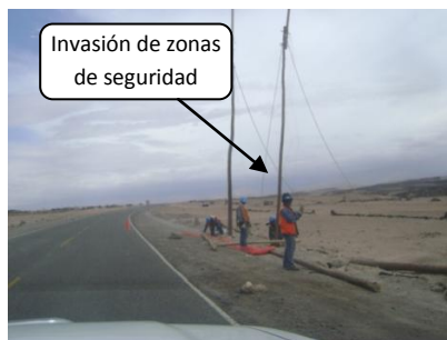
Progresiva Km 40+000, Instalación de postes eléctricos
