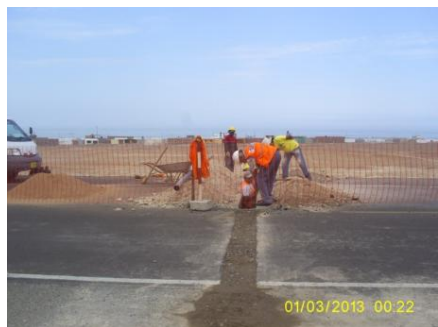
Progresiva 55+000, corte para pase de agua
