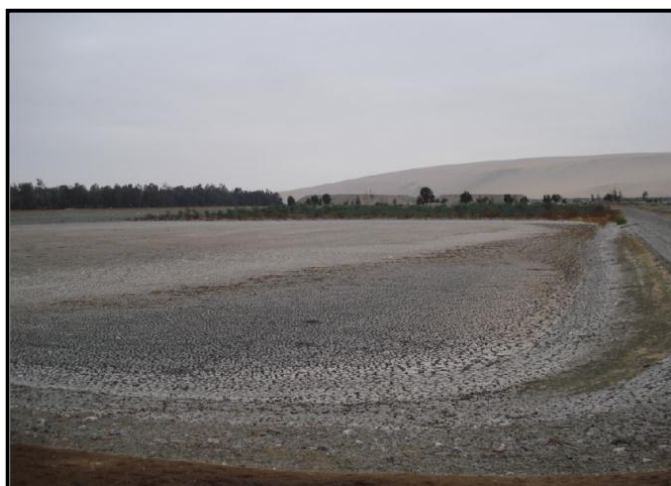
Anexo N° 22. Laguna N° 3 de la Planta de Magollo en proceso de secado, para su posterior limpieza.
