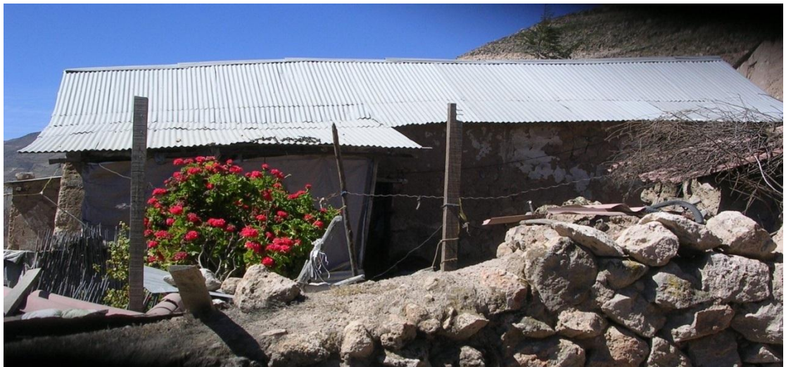
Fotografía 8: Vivienda del Centro Poblado de Ancocala. Se puede apreciar que la vivienda presenta 1 nivel, el sistema constructivo es en función al uso de adobe y cobertura a base de calamina galvanizada.
