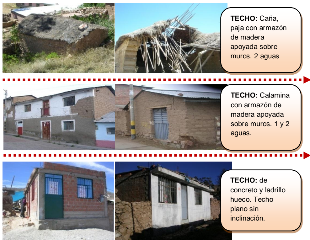
Figura 54. Vivienda del distrito de Cairani, material de cobertura predominante.
