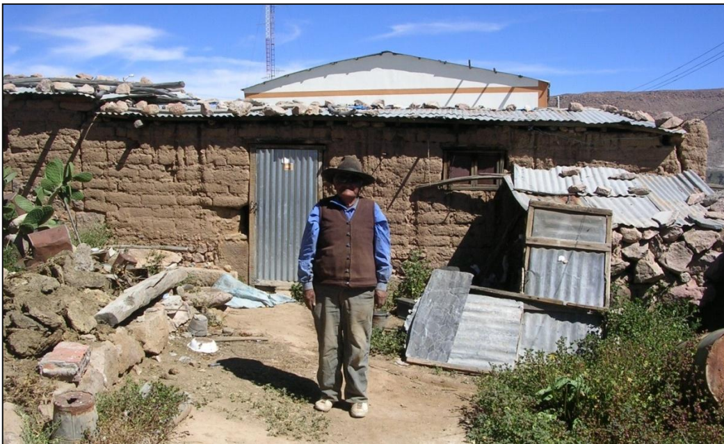
Fotografía 4: Vivienda ubicada en el pueblo de Cairani construida bajo el sistema tradicional de adobe, se puede apreciar la cobertura de calamina y el piso de tierra apisonada
