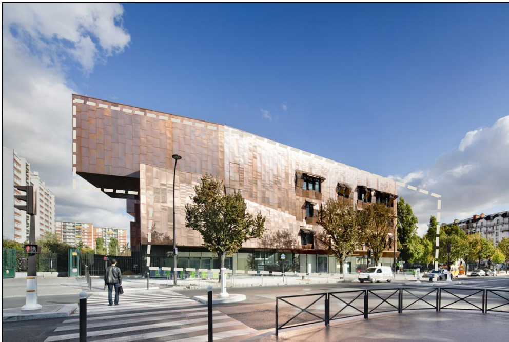
Figura 30. Vista de la fachada principal del conservatorio
