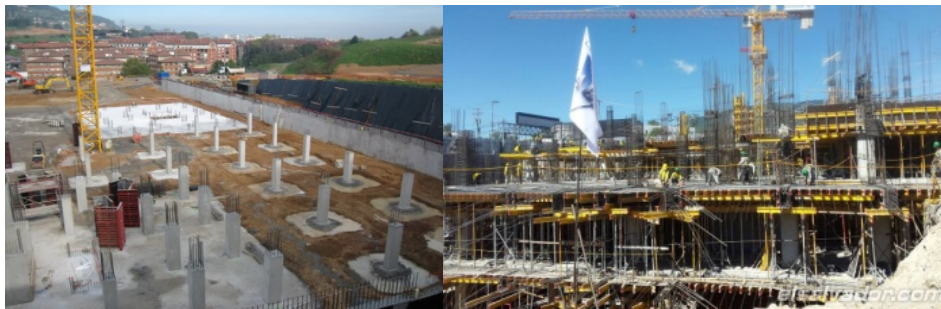
Figura N° 41: Proceso de Cimentación
