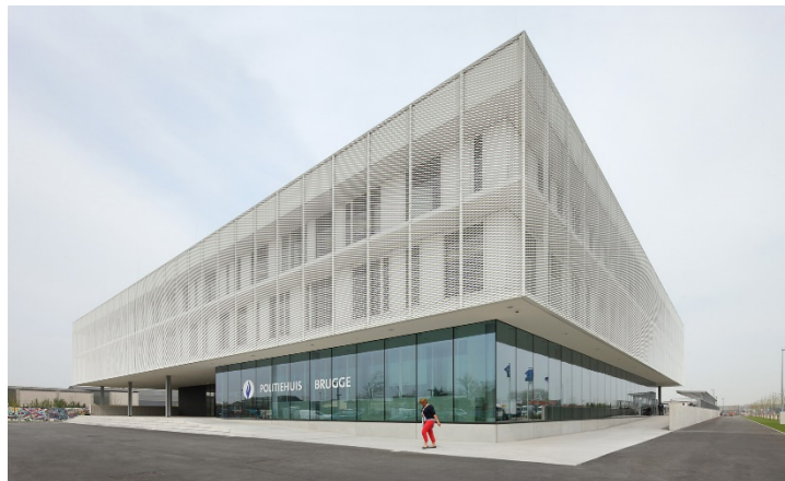
Figura N° 2: Fachada Principal del POLITIECOMMISSARIAAT BRUGGE
