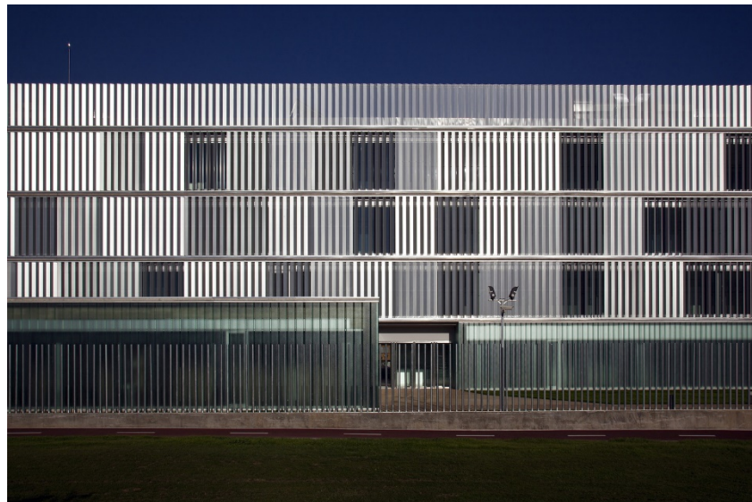
Vista de la fachada y materiales de construcción
