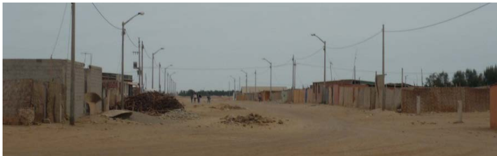
Vista desde la Avenida Grau (predomina el uso residencial, se aprecian viviendas en proceso de consolidación)
