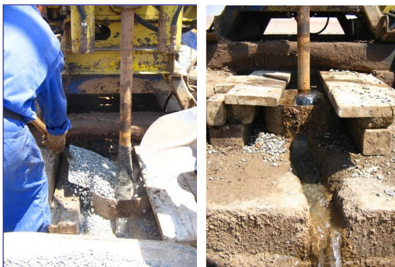
FOTOS Nº 20 y 21: En las fotos se observa el engravado con grava seleccionada de 3 a4 mm Ø y el lavado del pozo con abundante agua desde el fondo hacia arriba.
