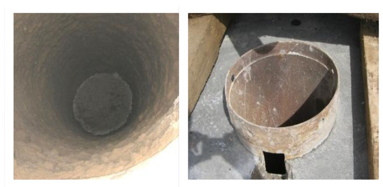
FOTOS Nº 14 y 15: Obsérvese el cementado del prepozo PEL-1 y en la foto de la derecha el acabado final, con un casing metálico de 15" Ø.
