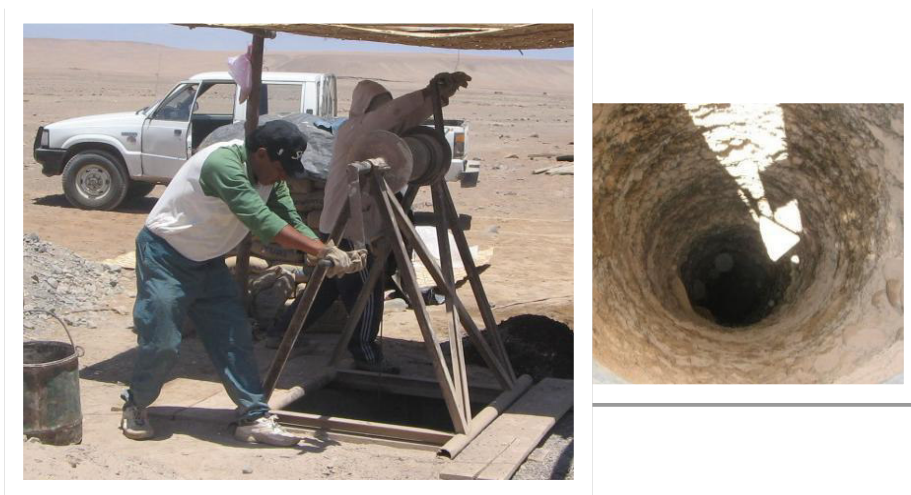
FOTOS Nº 12 y 13: Prepozo PEL-1, excavación a mano, el material extraído del fondo del, es subido a la superficie a través de un recipiente, accionado por un torno manual.
