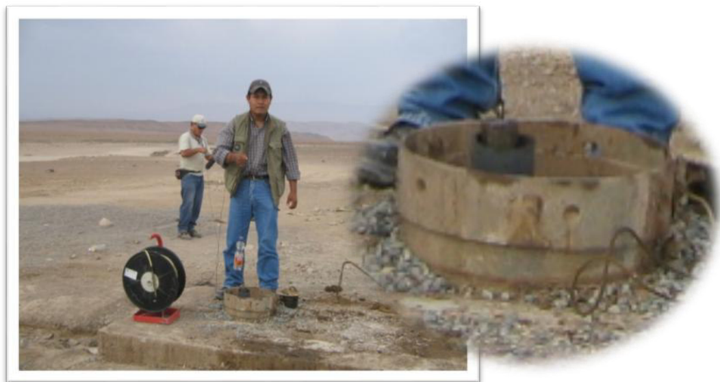
Foto N° 24 y 25. Pozo PEL-01, de 0.00 m. a 95.40 m. con un diámetro de 4 ¾" Ø y de 95.40 m. a 274.00 m. con 3" Ø., encamisado con tubería de PVC ciego y ranurado de 3" Ø clase 15, tal como se observa en la foto.
