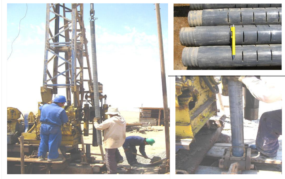
FOTOS Nº 17, 18 y 19: En las fotos se observa el entubado del pozo PEL-1 con tubería de PVC de 3" Ø x 2.96 de longitud.
