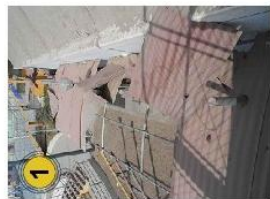
1 PERGOLAS DE ESTRUCTURA ALUMINIO Y COBERTURA EN MAL ESTADO
