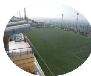
LOSA DEPORTIVA ASOC.DE VIV.LOS BALCONCILLOS"
