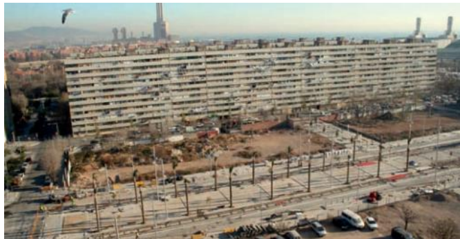
Imagen 46: La Rambla de La Mina en construcción
