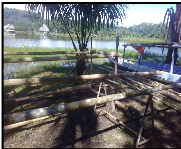
Figura 28. Armazón elaborado de bambú para las jaulas flotantes.
