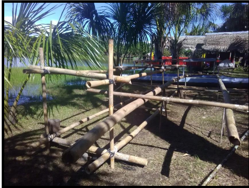
Figura 29. Estructuras de bambú de las jaulas flotantes de acuerdo con las dimensiones requeridas.
