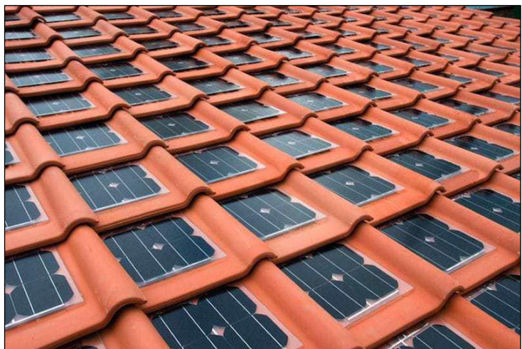
IMAGEN 57. TEJAS SOLARES FOTOVOLTAICAS
