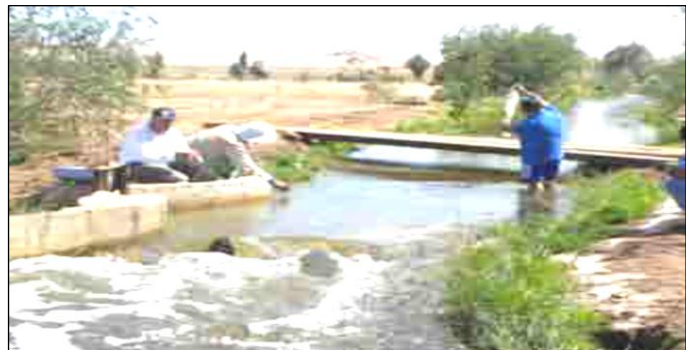
IMAGEN 64. FILTRACION DE QUEBRADA ONDA
