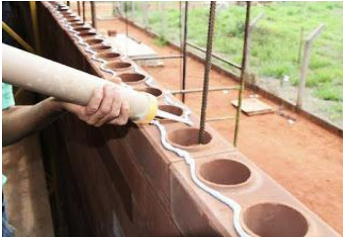
IMAGEN 51. ARMADO, PEGADO E INSTALACIÓN
