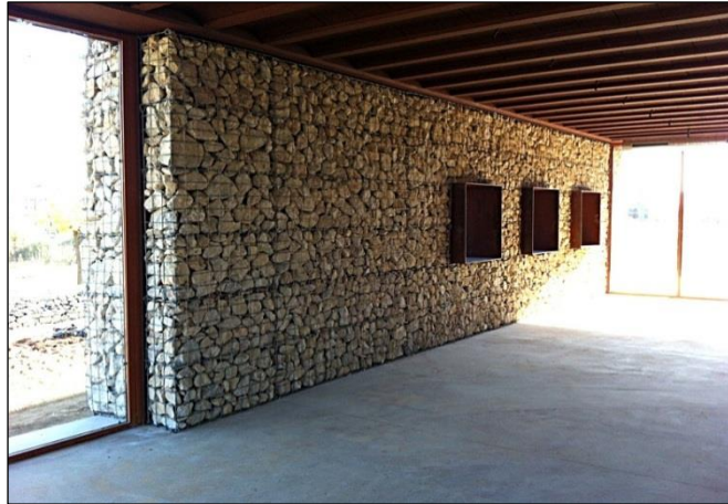
IMAGEN 89. PAREDES DE GAVION
