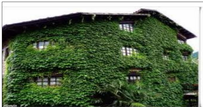
IMAGEN 47. FACHADA CUBIERTA DE VEGETACION
