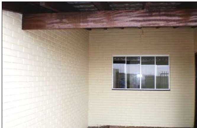
IMAGEN 52. ACABADO DE ECO-BLOCK
