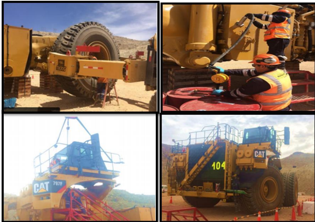
Figura 43. Foto armado de camión 797F
