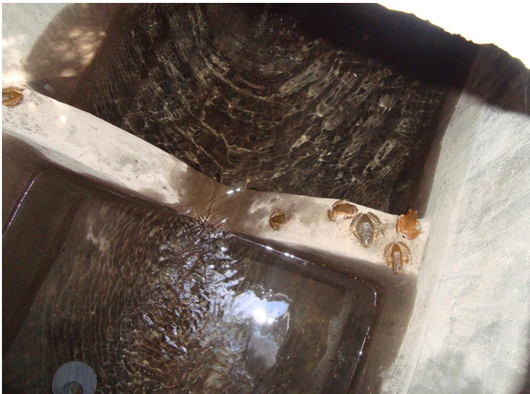
Foto N° 31: Presencia de anfibios en un sistema de abastecimiento de agua en Arondaya
