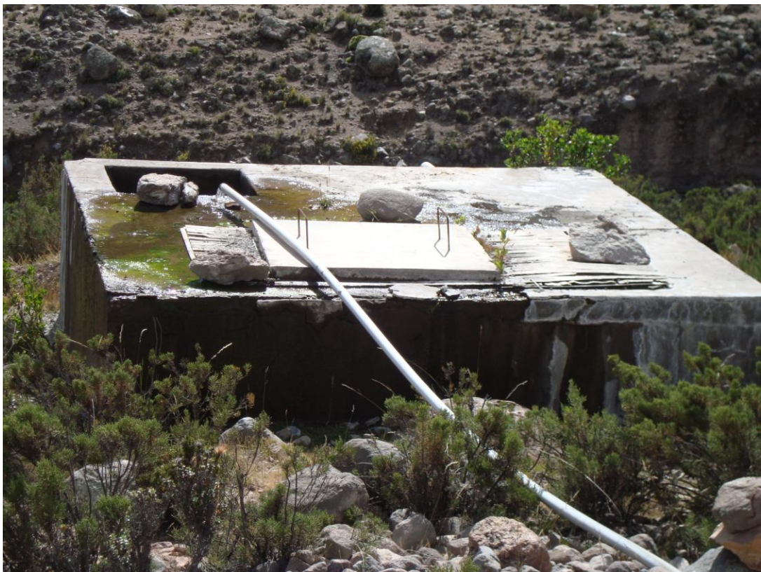
Foto N° 26: Sistemas de abastecimiento de agua para consumo humano que no cuenta con una buena infraestructura en Arondaya
