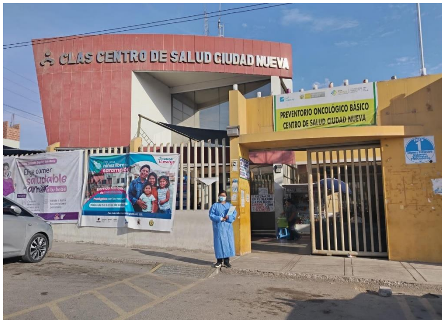
Fotografía N°1: Puerta principal de ingreso al C.S. Ciudad Nueva.
