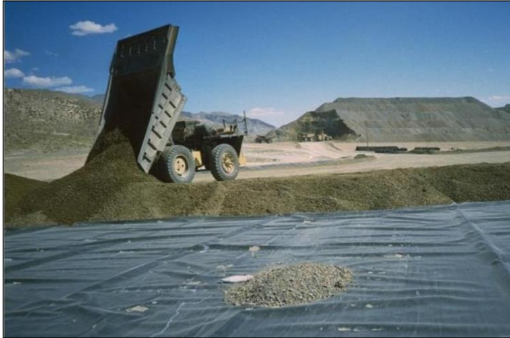
Figura 6. Construcción de la pila de lixiviación Fuente: Broggi, 2013
