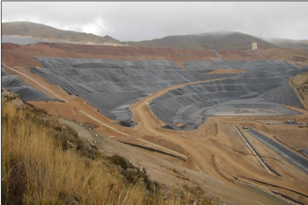
Figura 5. Esquema de una pila de lixiviación – base permeable Fuente: Broggi, 2013
