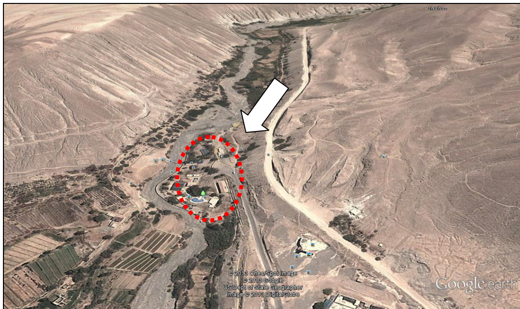
Figura 43: Bocatoma Calientes y Baños Termales
