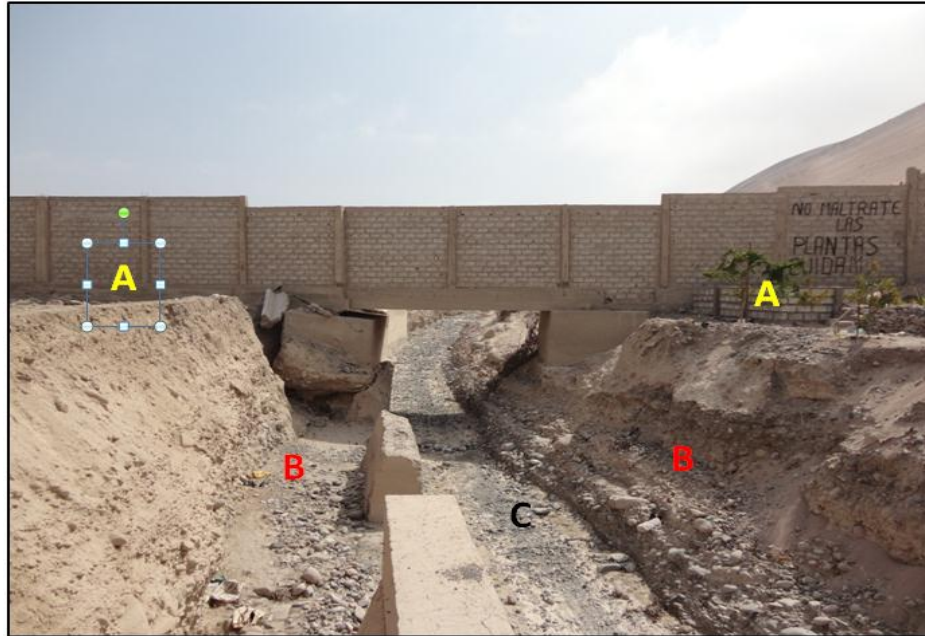
Figura 39: La vista muestra la conformación de los diferentes tipos de lecho A: Lecho Mayor o de inundación B: Lecho Ordinario o aparente C: Lecho o canal de estiaje.
