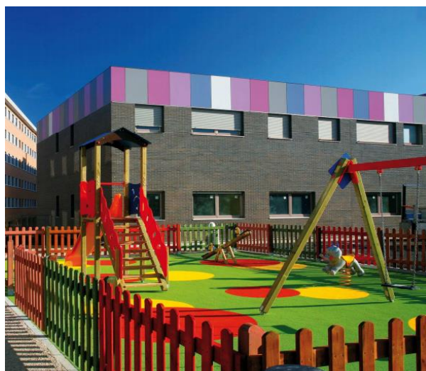
IMAGEN N° 4: VISTA EXTERIOR “CASA MALVA”, IDENTIFICACIÓN DE VANOS EXTERIORES
