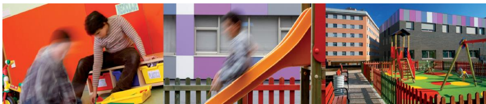
IMAGEN N° 3: VISTA EXTERIOR “CASA MALVA”, IDENTIFICACIÓN DE VANOS EXTERIORES.
