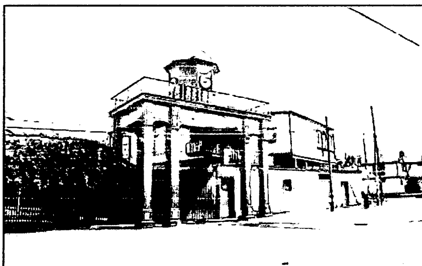
IMAGEN N° 21 ESTACIÓN FERROVIARIA DE TACNA
