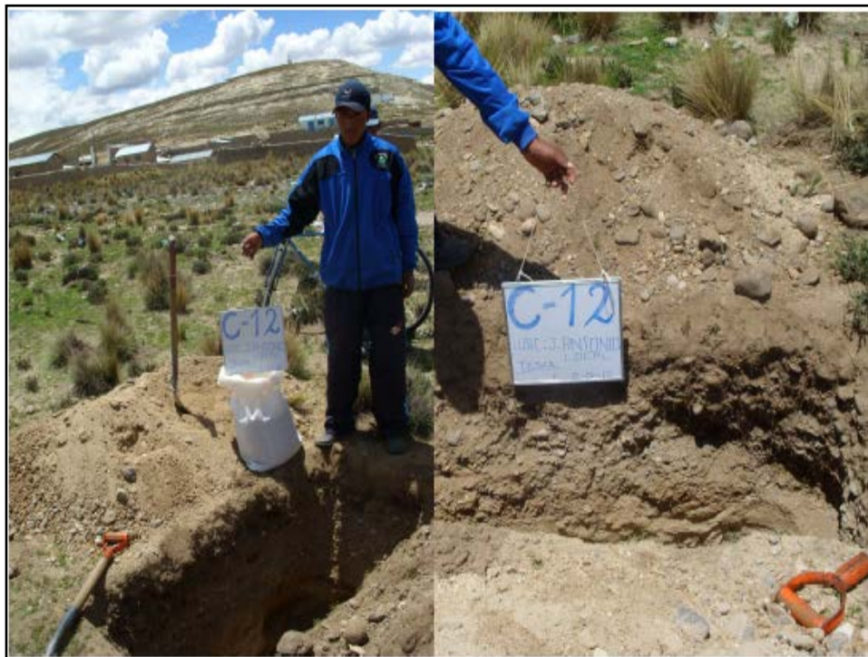
Foto 19. Vista y perfil estratigráfico de la calicata C-12, ubicado al posterior del local del Barrio José Antonio.
