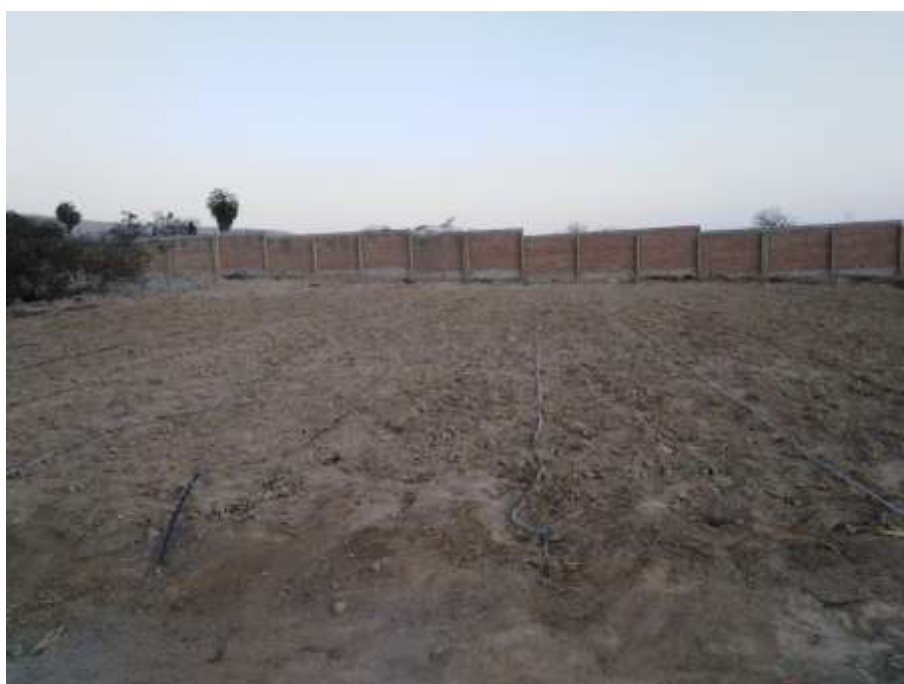
Fotografía 2. Nivelación y tendido de cinta
