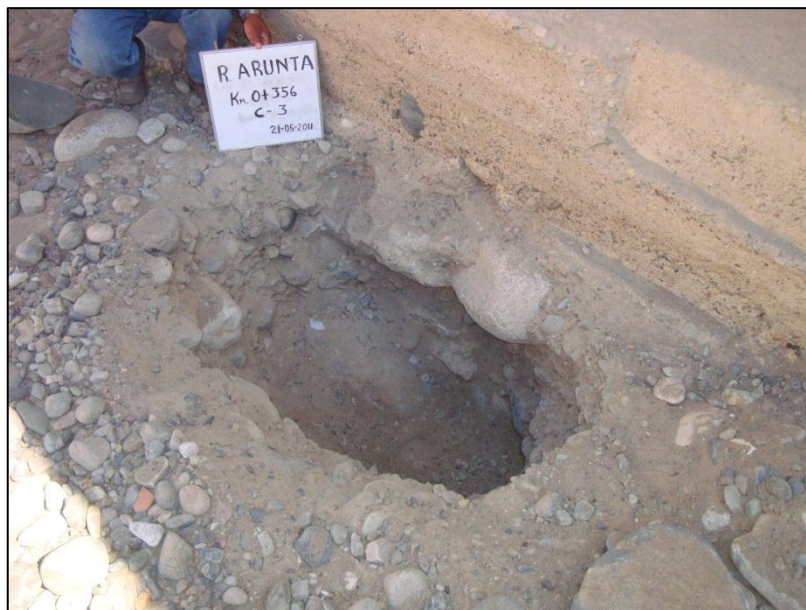
Figura 6: Calicata Nº 03, en la cimentación del muro se observan gravas arenosas pobremente gradadas, cantos rodados y bolones.
