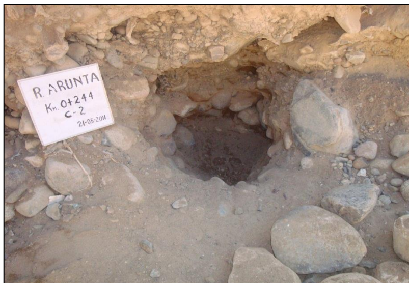
Figura 5 : Calicata Nº 02, ubicada por debajo de la cimentación del muro de Contención cerca de la progresiva 0+244.
