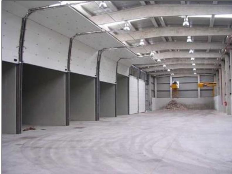
Imagen 40. Vista interior de túneles de fermentación
