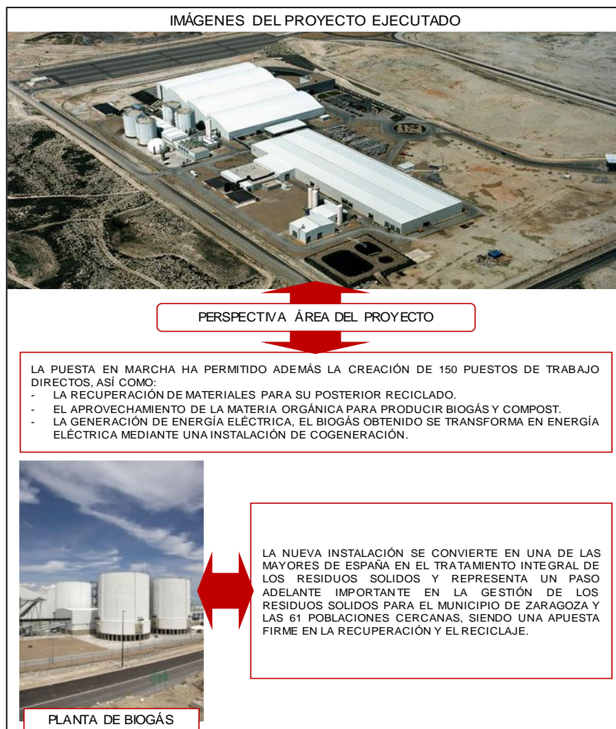
Imagen 62. Complejo para el tratamiento de residuos urbanos de Zaragoza
