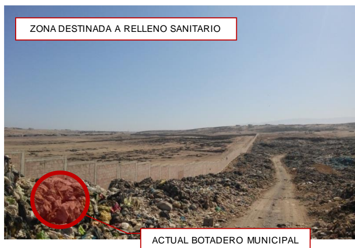
Imagen 71. Arrojo de residuos sólidos de manera inadecuada y clandestina
