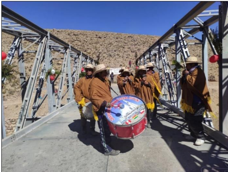
Puente Carrozable en el Río Maure concluido
