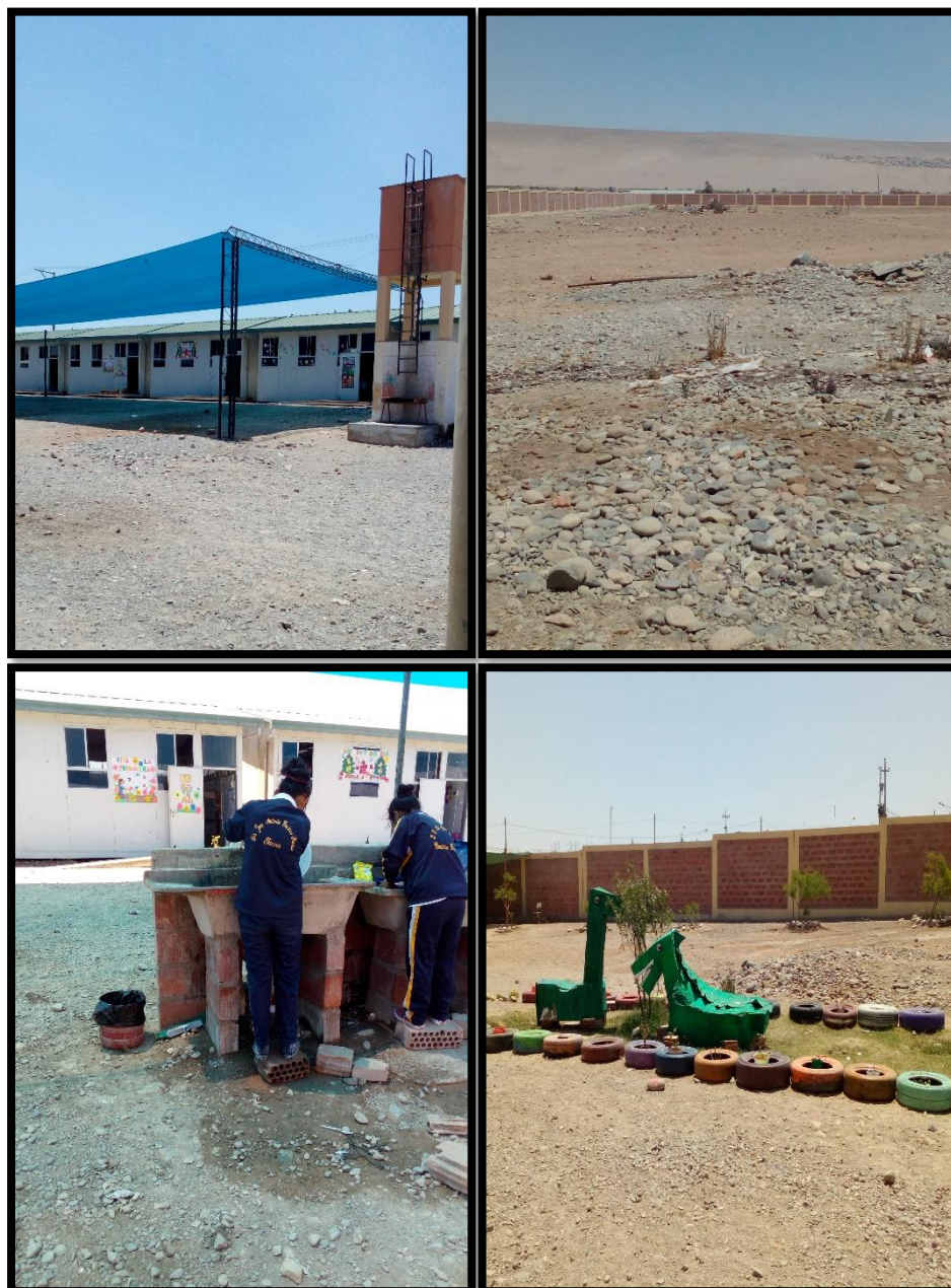
Figura 3. A: Reservorio de agua con falta de manteniendo, B: presencia de animales que viven en la institución, C: acumulo de agua, D: lugar de juego de niños en contacto directo con la tierra.
