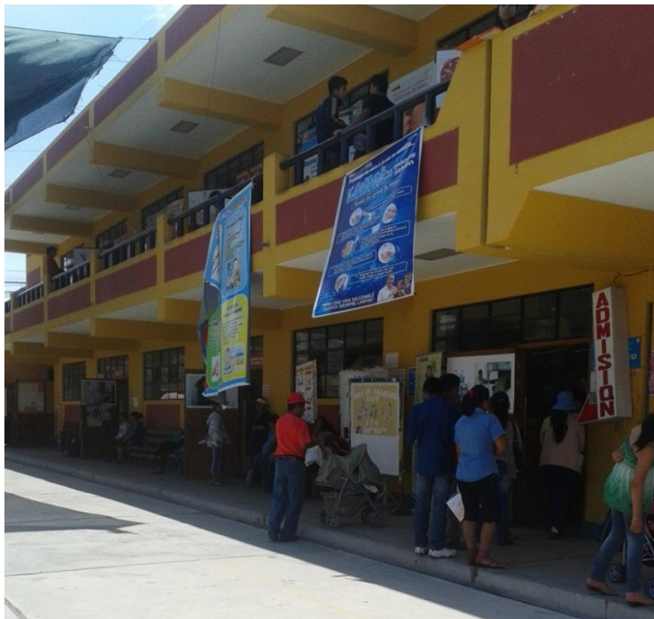
Actual equipamiento usado para la prestación del Servicio de Salud del Centro de Salud San Francisco
