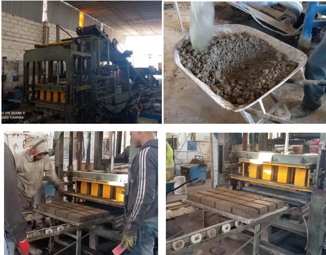
Elaboración de los adoquines de concreto
