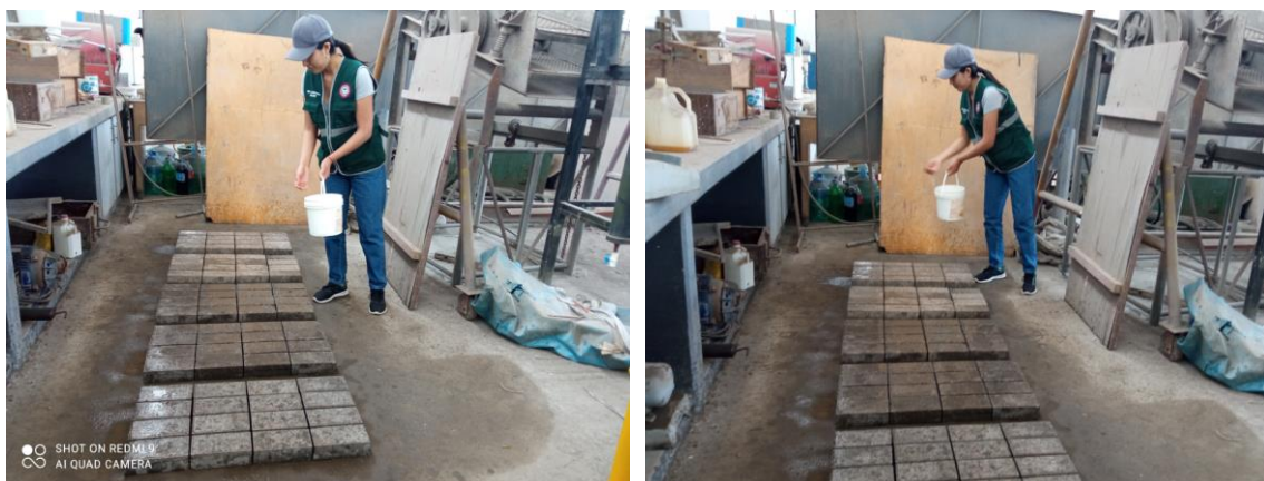
Curado de los adoquines de concreto
