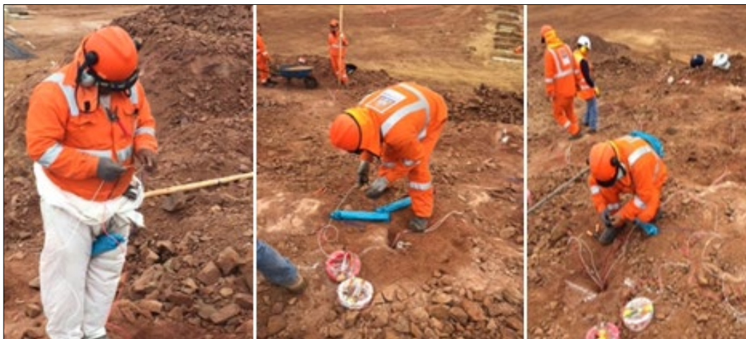
Ilustración 9. Amarre de cargas en los pozos de perforación Fuente: ENAEX, 2019b.
