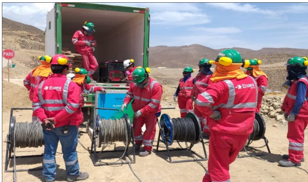
Ilustración 10. Instalación del iniciador con el generador eléctrico Fuente: ENAEX, 2019b.
