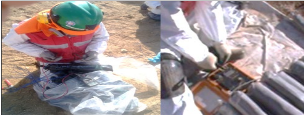
Ilustración 7. Verificación de calidad de las cargas con multítester Fuente: ENAEX, 2019b.
