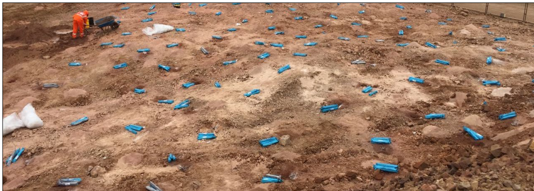
Ilustración 8. Distribución de cargas en los pozos de perforación Fuente: ENAEX, 2019b.
