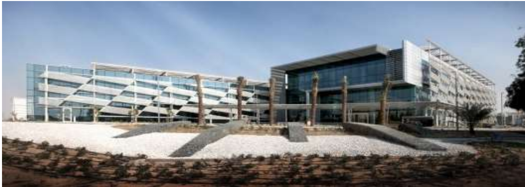
Figura 5. Vista del ingreso principal al Centro de Diálisis Mafraq / Stantec Fuente: Erik Hokanson, AIA, Tamer Fawzi, Reham Hussein, Abhishek Gupta, Wafaa Sleiman (2012)
