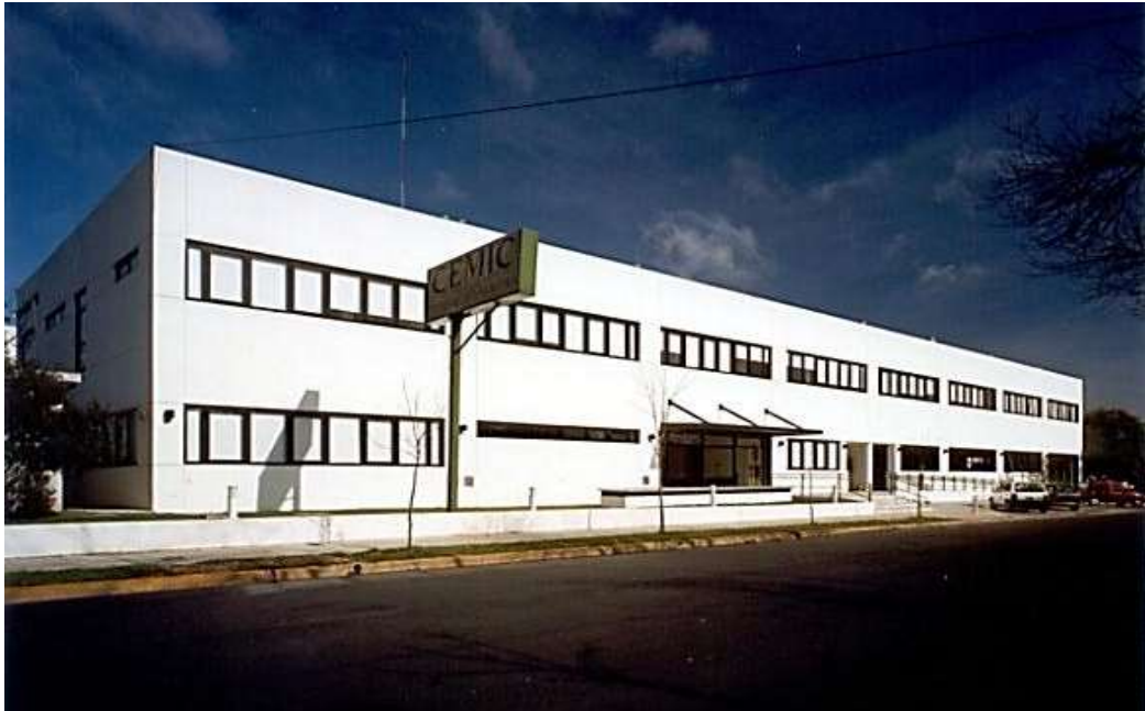
Figura 9. Vista general Centro de diálisis CEMIC
