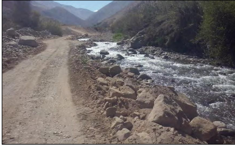
Fotografía 6. Estación LOC-04, río Ilabaya, aguas arriba (con obras de descolmatación).
