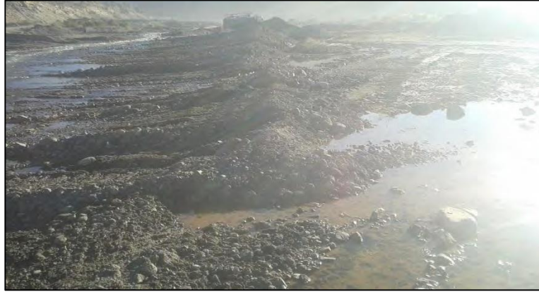
Fotografía 14. Estación CALL-01, río Callazas, aguas abajo (obras de descolmatación)
