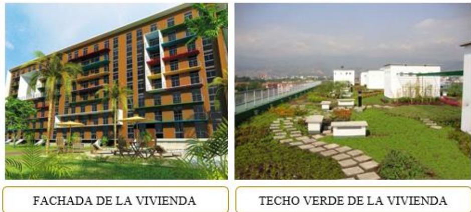
Figura 27. Vivienda del Complejo residencial sayab en cali, Colombia. Fuente : http://apuntesdearquitecturadigital.blogspot.pe/2014/01/100-proyectos-de-arquitectura_597.html
