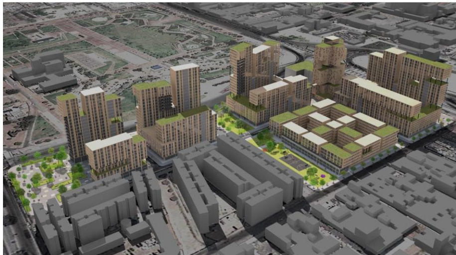
Figura 11. Imagen del costado sur del Proyecto.
