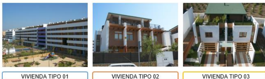
Figura 19. Fachada de Vivienda del complejo Residencial Liri Blau. Fuente: http://apuntesdearquitecturadigital.blogspot.pe/2013/08/100-proyectos-de-arquitectura.html .
