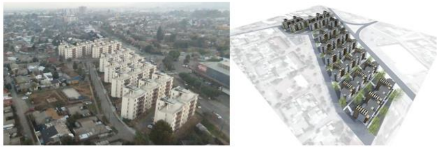
Figura 23. Fachada de Vivienda del Conjunto Habitacional Social Monseñor Larraín.
