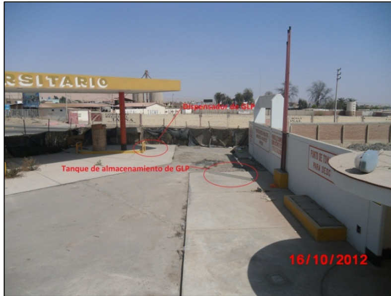
Figura 46. Vista del área donde se proyecta instalar el dispensador y tanque de GLP
