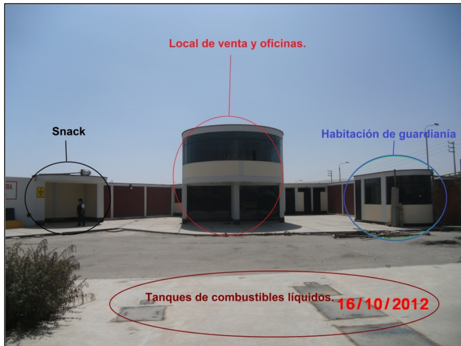
Figura 45. Vista de locales construidos en el grifo
