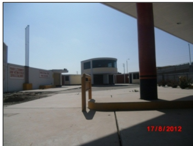
Figura 39. Vista de las edificaciones existentes del establecimiento
