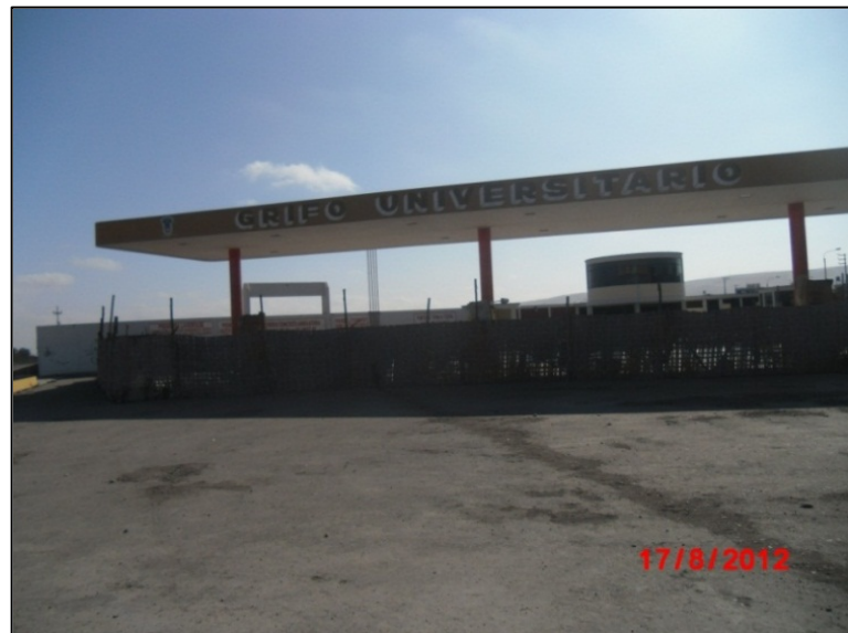
Figura 41. Vista del cerco que rodea el establecimiento
