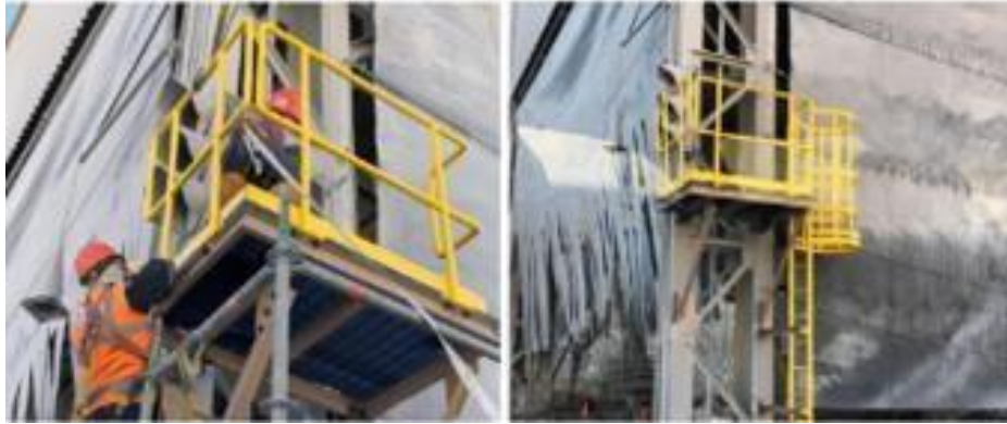
Figura 9. Instalación y montaje de plataformas. Fuente: empresa NCK Ingenieros E.I.R.L. (2018)
