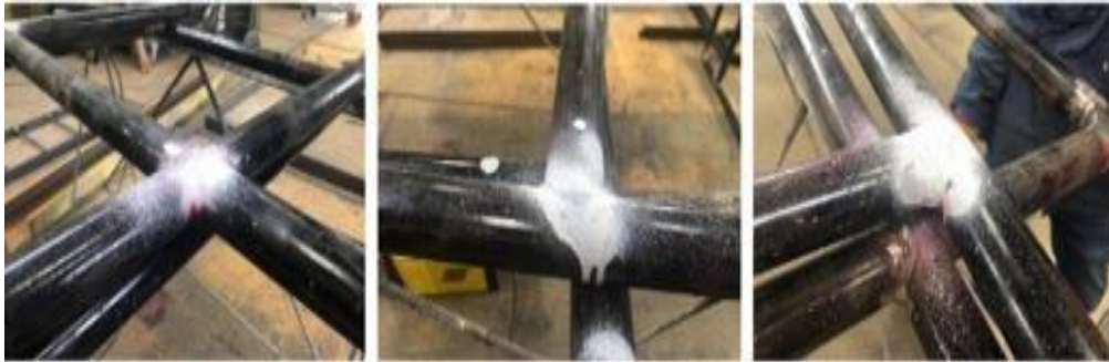
Figura 6. Prueba de tintes penetrantes Fuente: Empresa NCK Ingenieros E.I.R.L. (2018)
