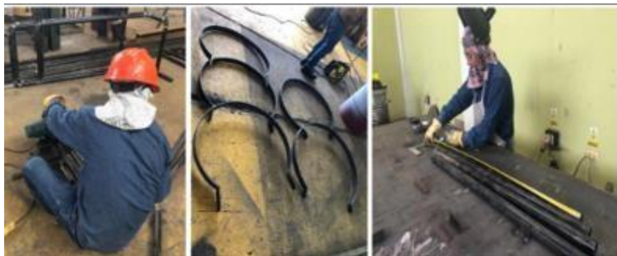
Figura 3. Habilitado de materiales. Fuente: empresa NCK Ingenieros E.I.R.L. (2018)
