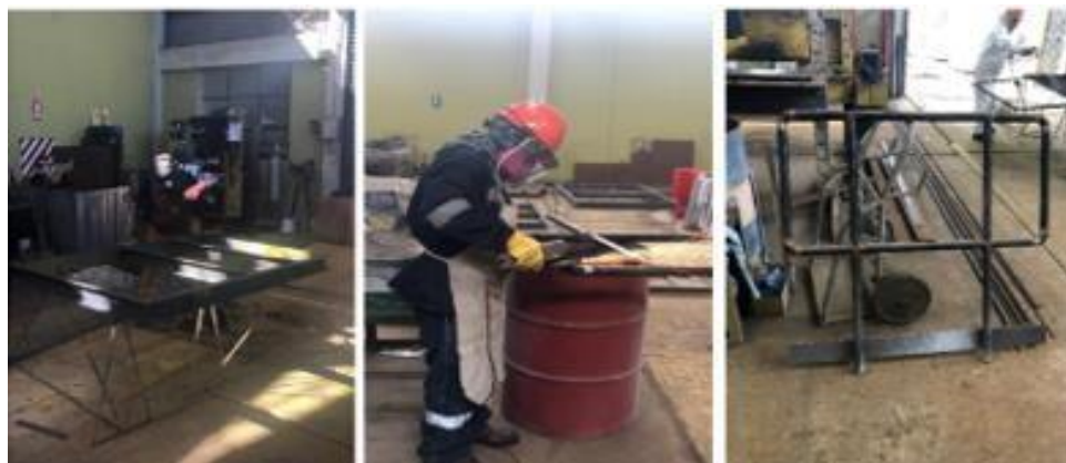
Figura 4. Apuntalado y soldeo de estructuras Fuente: empresa NCK Ingenieros E.I.R.L. (2018).
